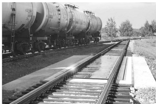
Рисунок 2 – Общий вид ГПУ весов
