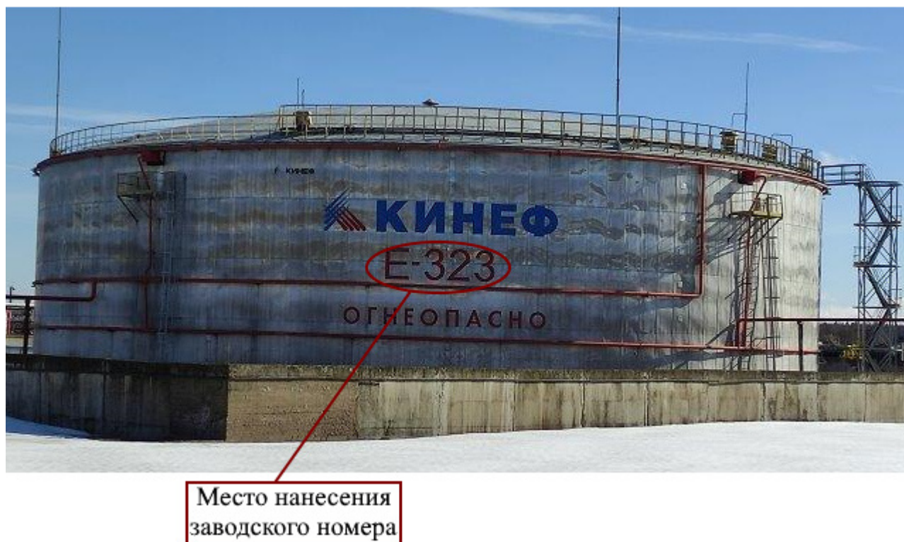
Рисунок 1 – Общий вид резервуара РВС-20000 зав.№ E-323 с указанием места нанесения заводского номера
