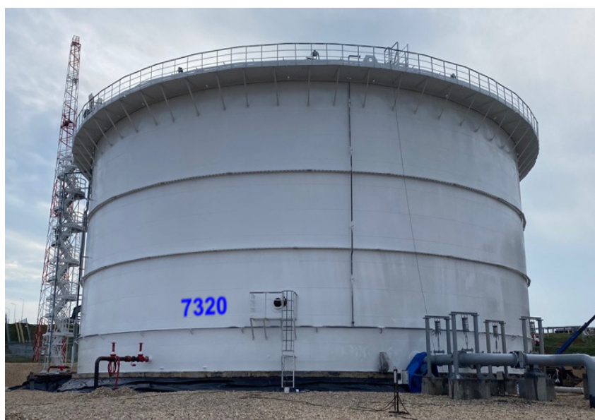
Рисунок 2- Общий вид резервуара РВСПК-20000, зав.№ 7320
