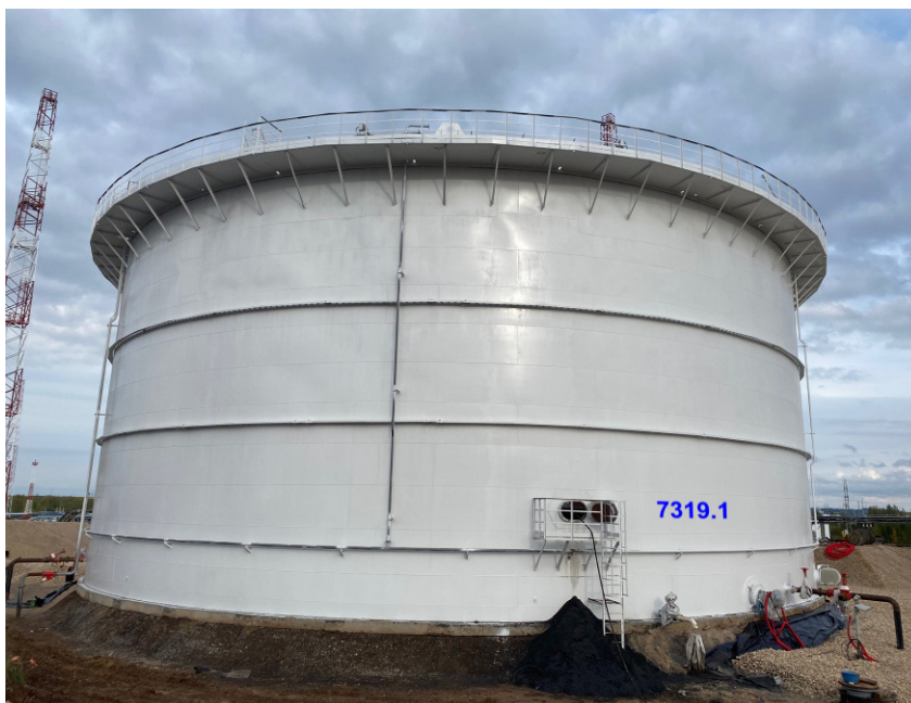
Рисунок 1- Общий вид резервуара РВСПК-20000, зав.№ 7319.1
