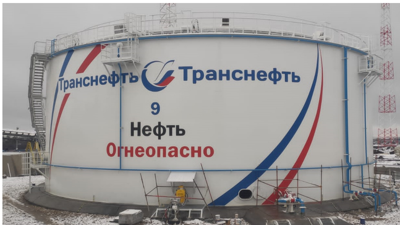
Рисунок 1 – Общий вид резервуара РВСП-10000 №9
