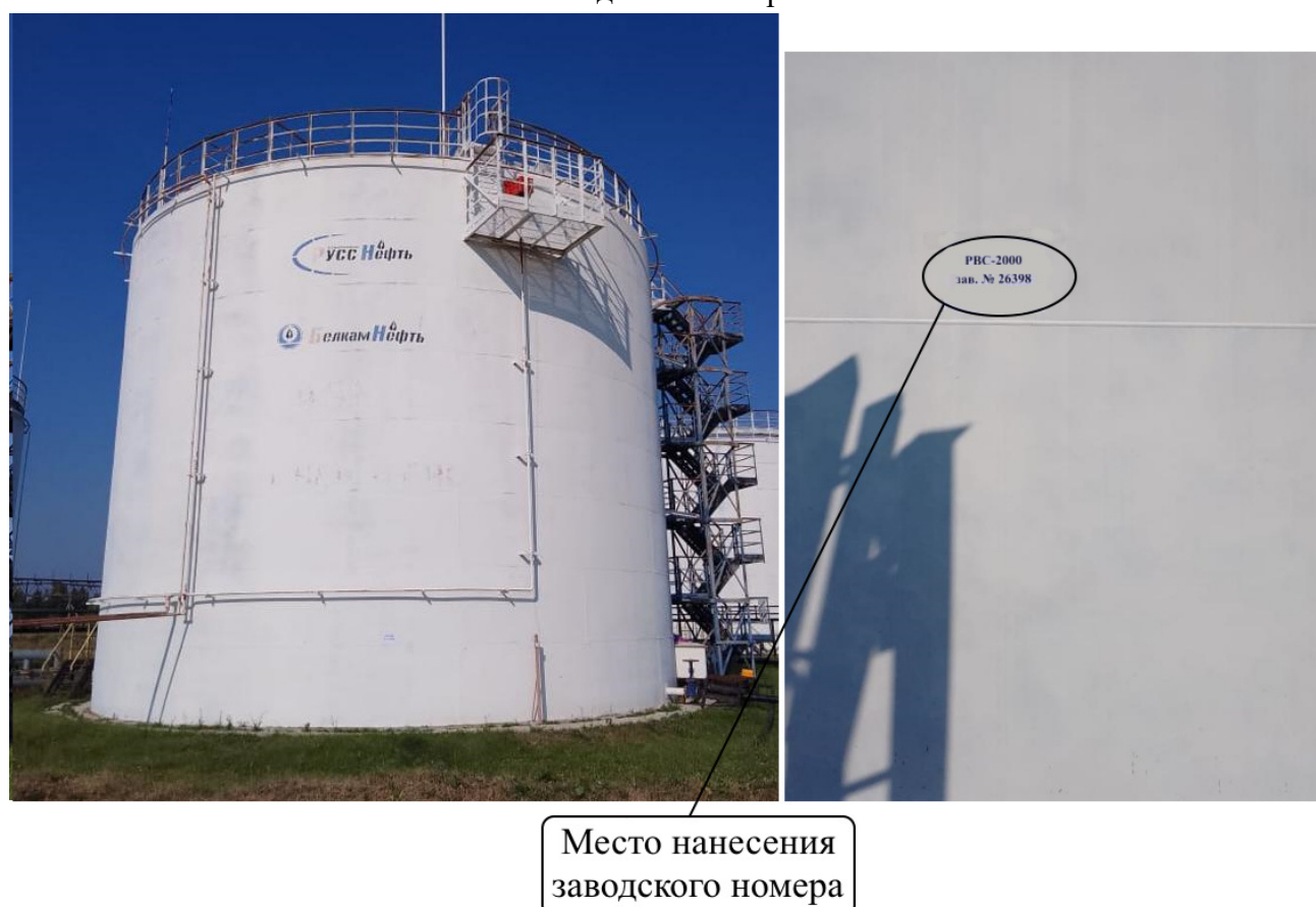
Рисунок 2 – Общий вид резервуара РВС-2000 №26398 с указанием места нанесения заводского номера
