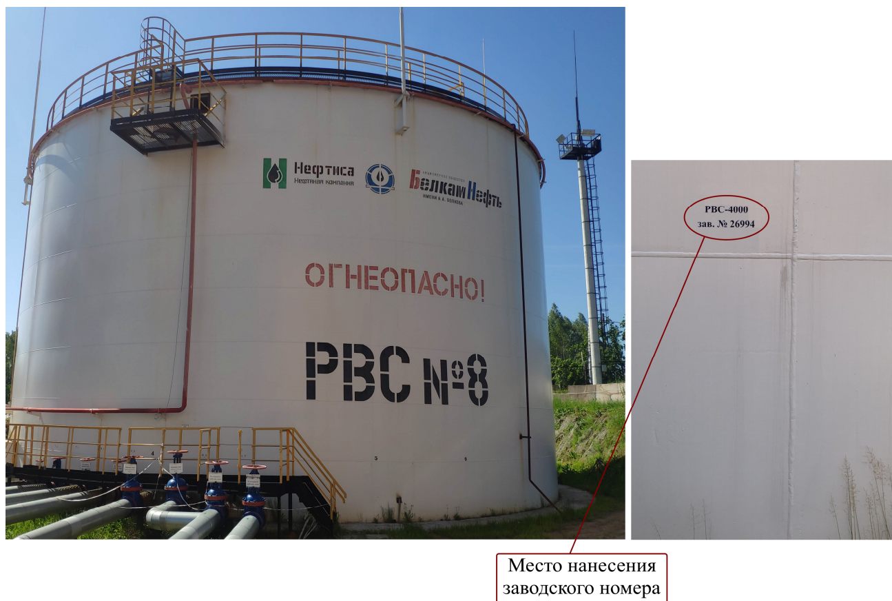
Рисунок 1 – Общий вид резервуара РВС-4000 №26994 с указанием места нанесения заводского номера
