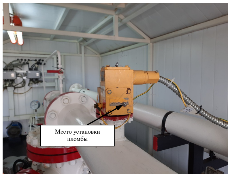
Рисунок 3 – Место установки пломбы на корпусе детектора
