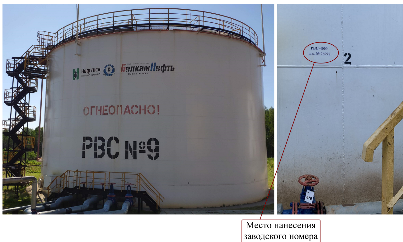
Рисунок 2 – Общий вид резервуара РВС-4000 №26995 с указанием места нанесения заводского номера
