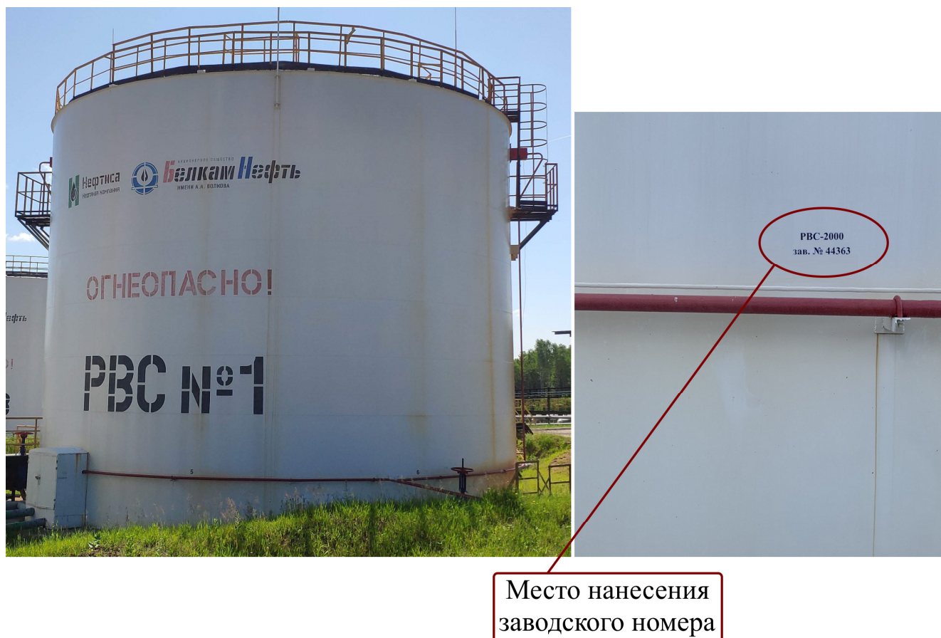
Рисунок 1 – Общий вид резервуара RBC-2000 с указанием места нанесения заводского номера Пломбирование резервуара RBC-2000 не предусмотрено.
