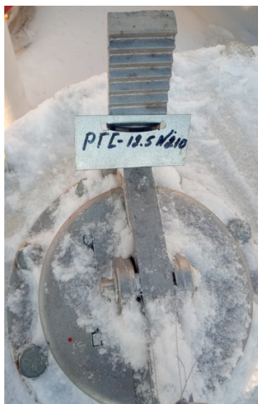
Рисунок 12 – Фотография горловины и заводского номера резервуара стального горизонтального цилиндрического РГС, модификации РГС-12,5, заводской номер 210
