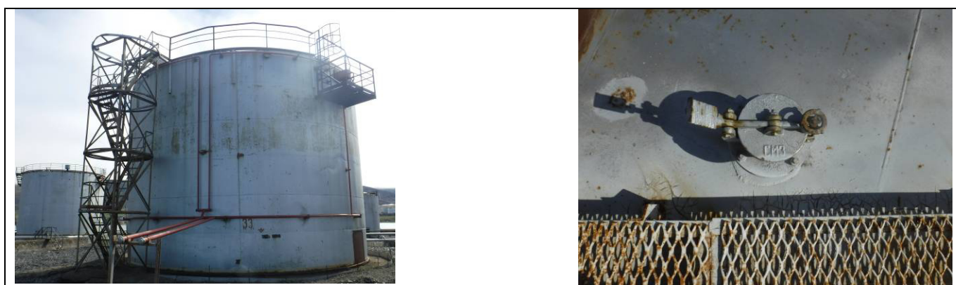
Рисунок 12 – Общий вид резервуара РВС-1000 (№33) с замерным люком
