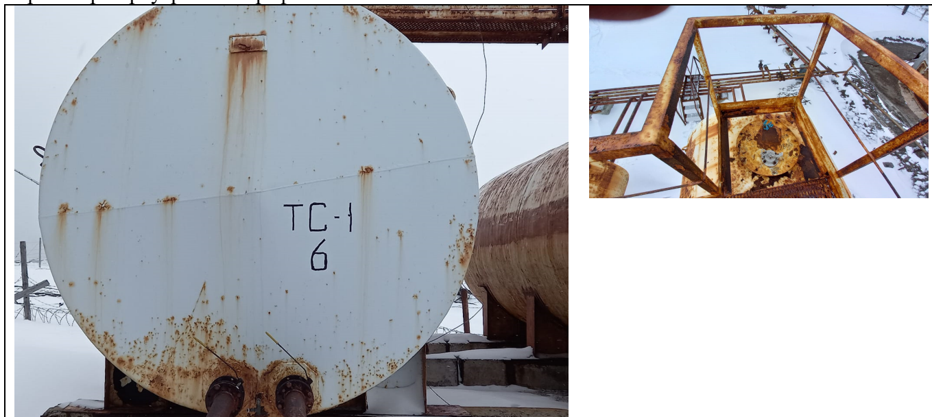
Рисунок 1 – Общий вид резервуаров РГС-60 (№6) с замерным люком
