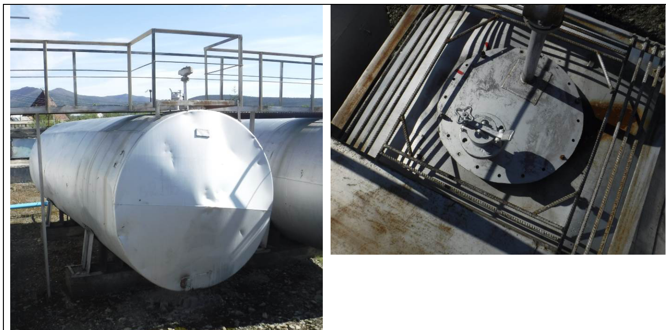
Рисунок 1 – Общий вид резервуаров РГС-50 (№26) с замерным люком
