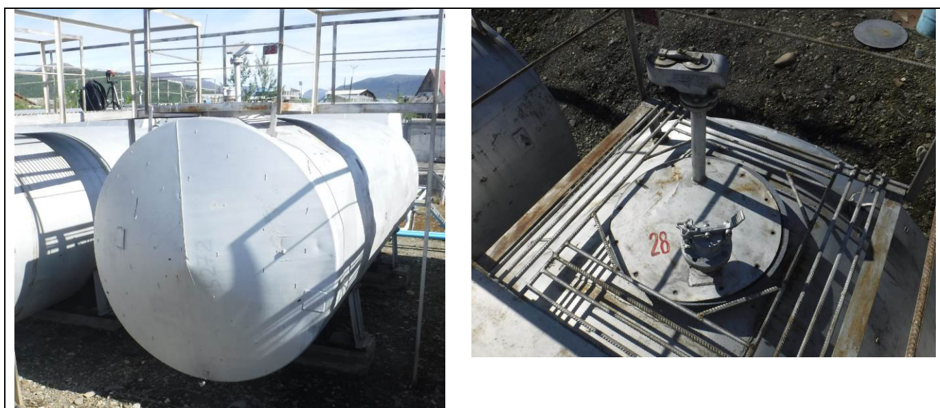
Рисунок 2 – Общий вид резервуаров РГС-50 (№28) с замерным люком
