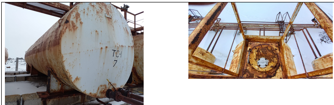
Рисунок 2 – Общий вид резервуаров РГС-60 (№7) с замерным люком
