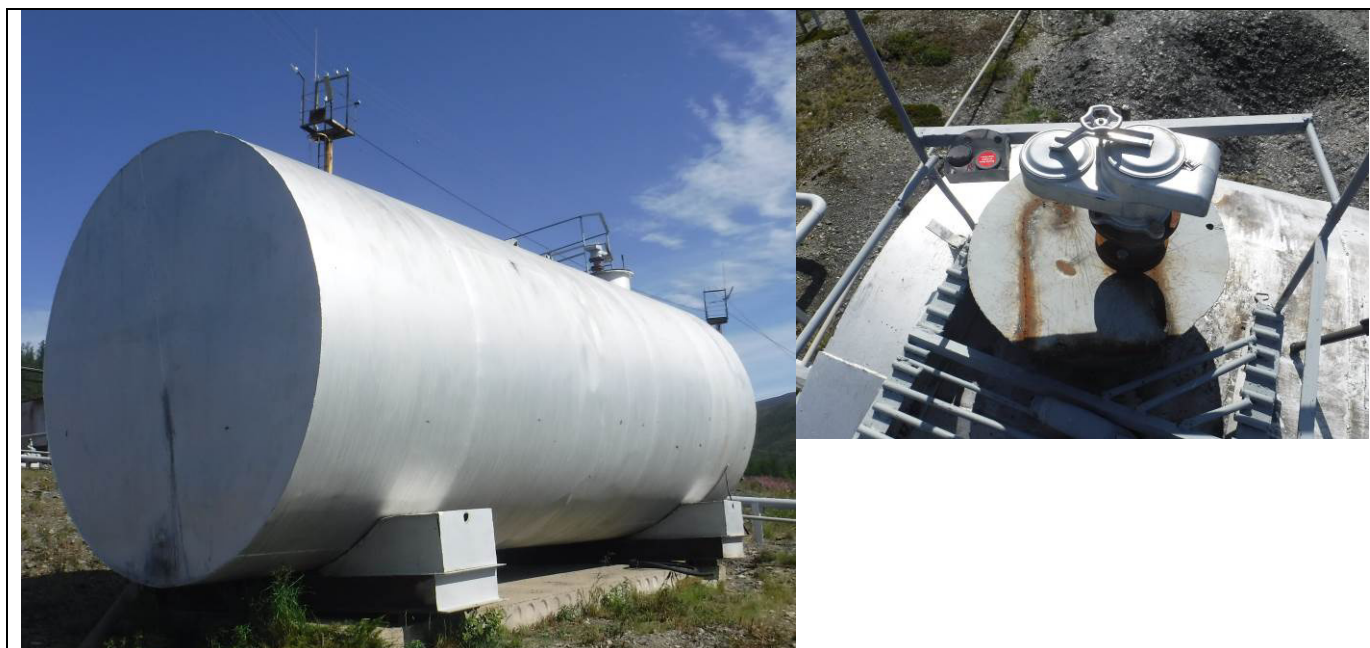
Рисунок 2 – Общий вид резервуаров РГС-50 (№8) с замерным люком
