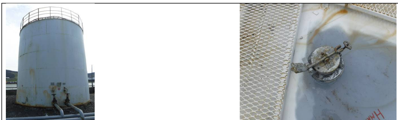
Рисунок 4 – Общий вид резервуара РВС-200 (№7) с замерным люком
