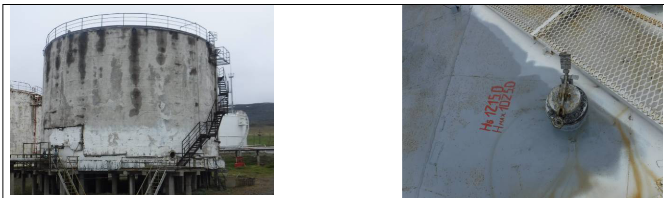
Рисунок 15 – Общий вид резервуара РВС-3000 (№51) с замерным люком
