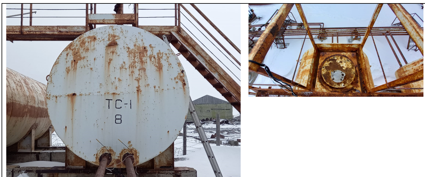
Рисунок 3 – Общий вид резервуаров РГС-60 (№8) с замерным люком
