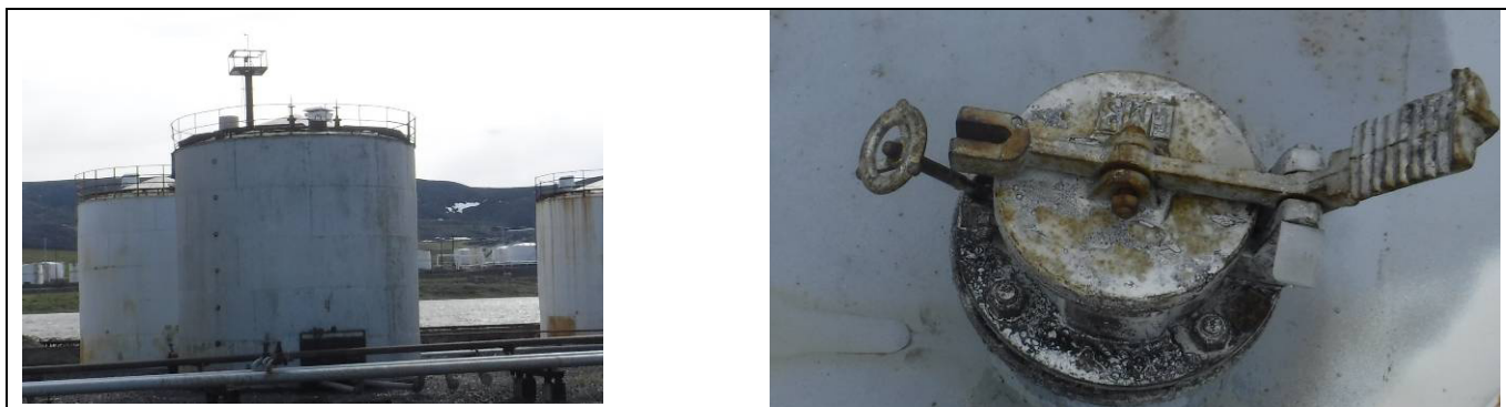
Рисунок 2 – Общий вид резервуара РВС-200 (№4) с замерным люком
