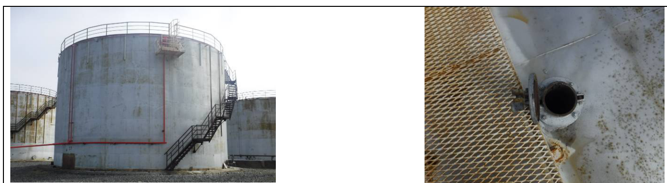
Рисунок 13 – Общий вид резервуара РВС-3000 (№37) с замерным люком
