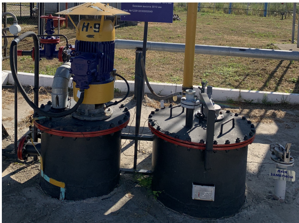
Рисунок 3 – Горловины и измерительный люк резервуара ЕП8-2000-1300-2 зав.№ 4730
