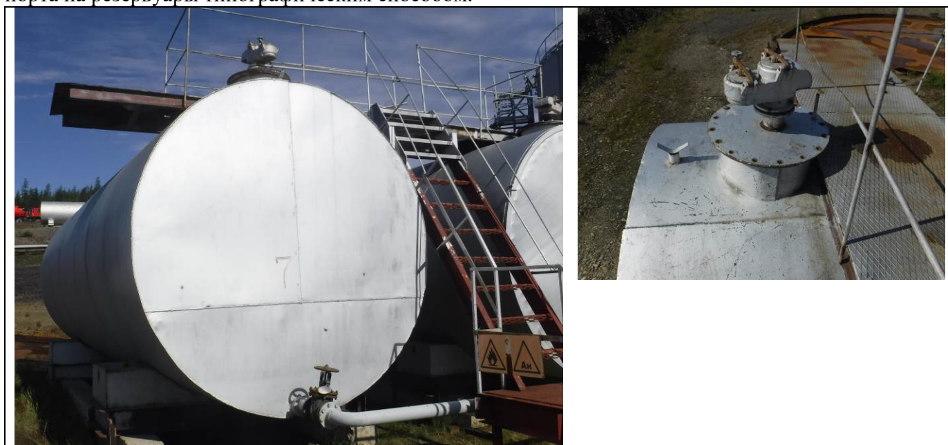
Рисунок 1 – Общий вид резервуаров РГС-50 (№7) с замерным люком
