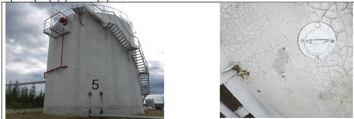
Рисунок 1 – Общий вид резервуаров РВС-700 (№5) с замерным люком
