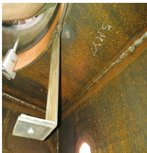
Рисунок 6 – Способ монтажа указателя уровня налива
