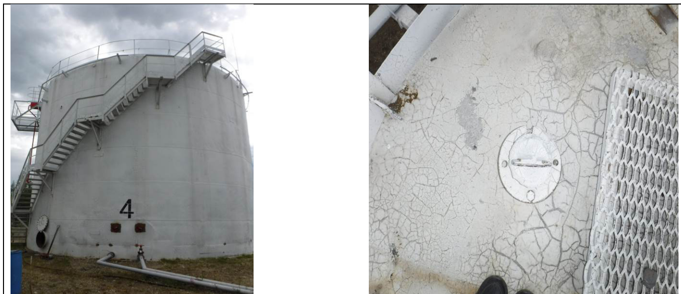
Рисунок 2 – Общий вид резервуаров РВС-1000 (№4) с замерным люком
