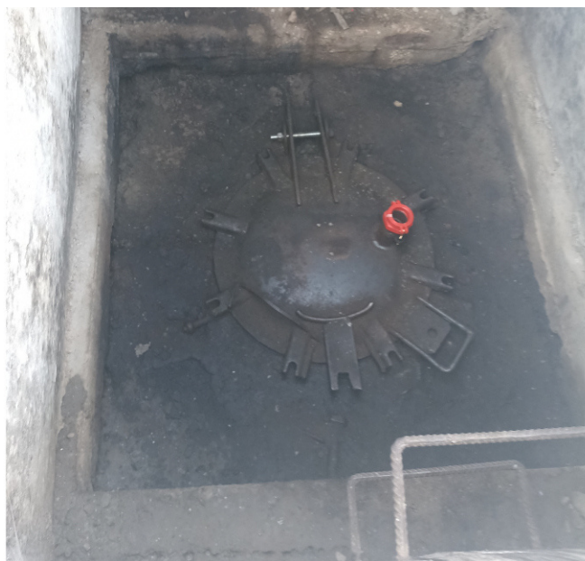
Рисунок 3 – Люк резервуара РГС-140 зав.№6 с указанием места нанесения заводского номера
