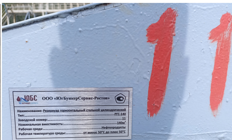
Рисунок 8 – Люк резервуара РГС-140 зав.№11 с указанием места нанесения заводского номера
