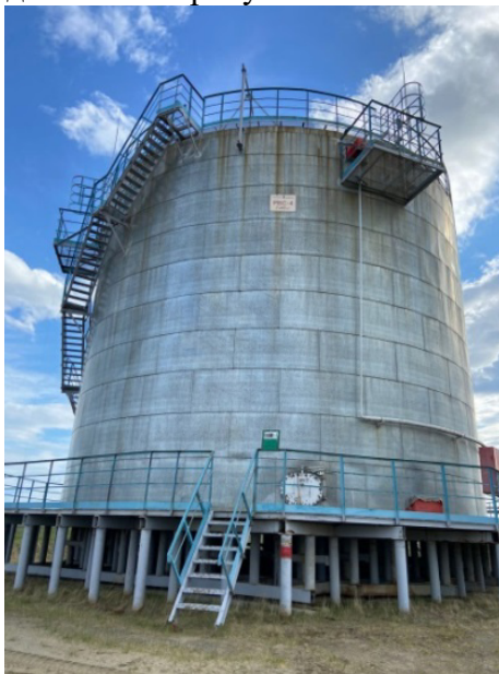
Рисунок 1 - Общий вид резервуара
