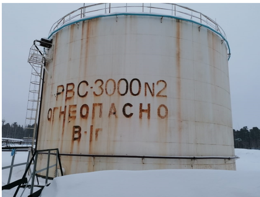
Рисунок 1 – Внешний вид резервуара стального вертикального цилиндрического РВС-3000
