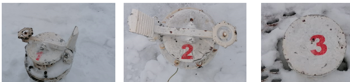
Рисунок 2 – Замерные люки резервуара стального вертикального цилиндрического РВС-3000
