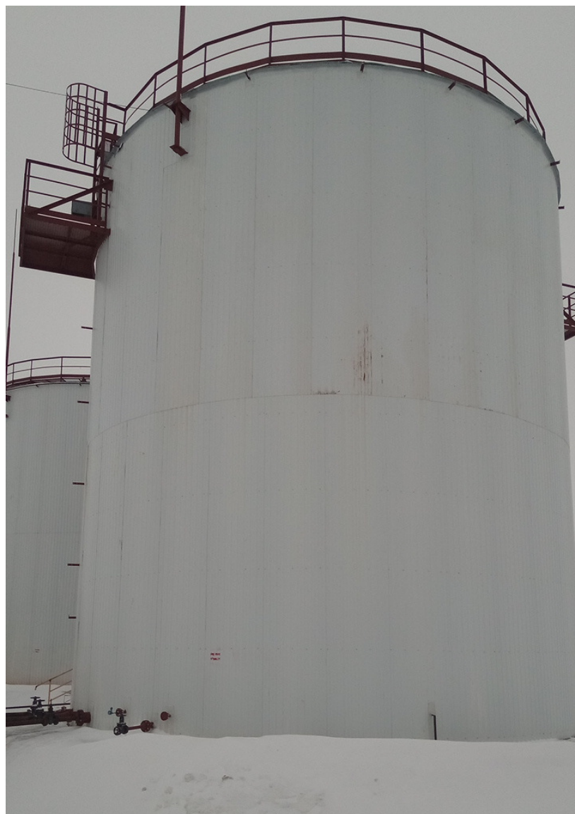
Рисунок 2 – Общий вид резервуара РВС-1500 с заводским номером 046/21
