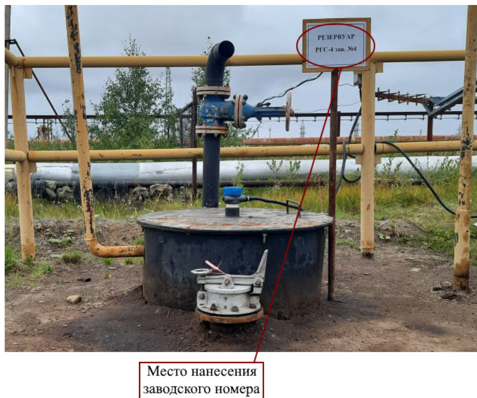
Рисунок 1 – Общий вид резервуара РГС-4 №4 с указанием места нанесения заводского номера
