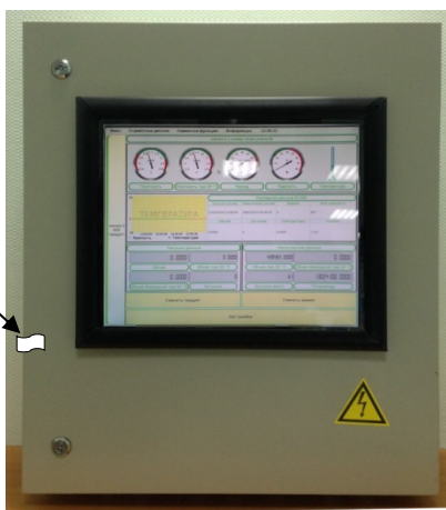
Фото 7. Шкаф УСПД Место пломбирования
