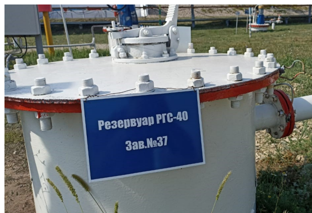
Рисунок 1 - Место нанесения заводских номеров резервуаров РГС-40
