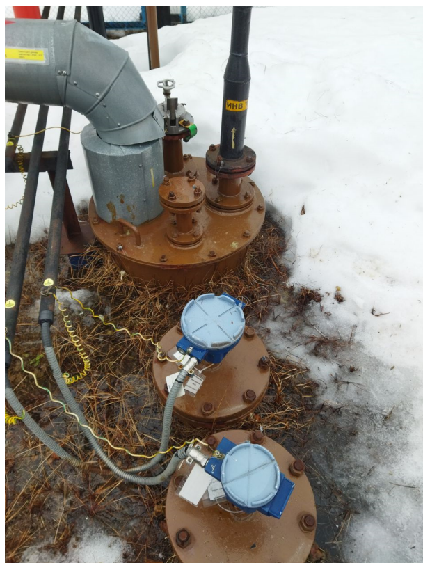
Рисунок 2 – РГС-3 на месте установки
