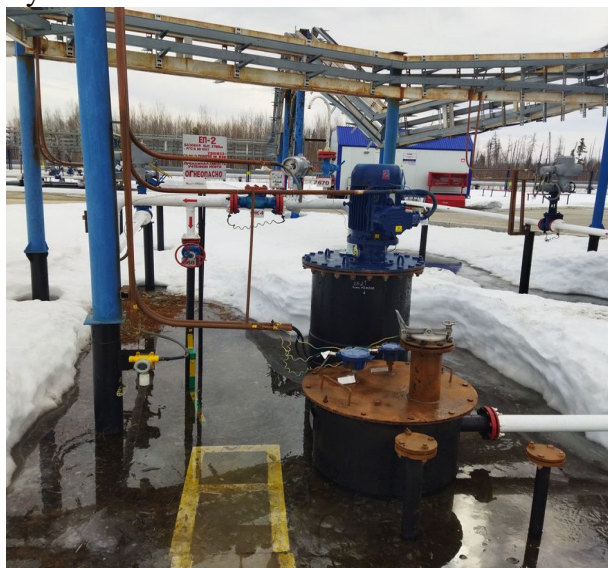
Рисунок 1 – РГС-8 на месте установки
