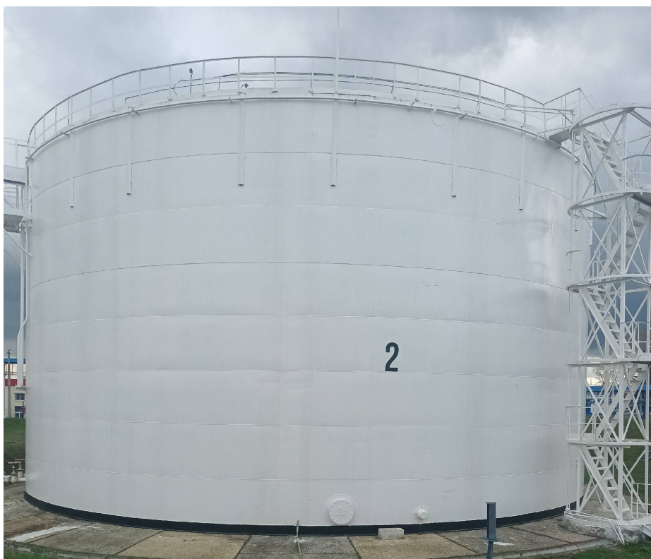
Рисунок 2 - Общий вид резервуара № 2
