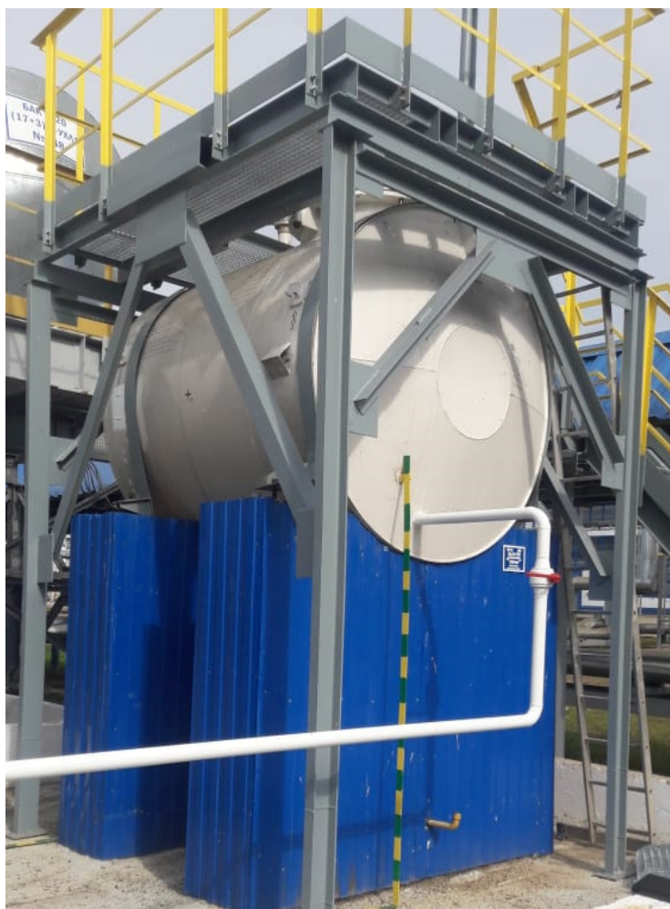
Рисунок 1 - Общий вид резервуара РГС-5
