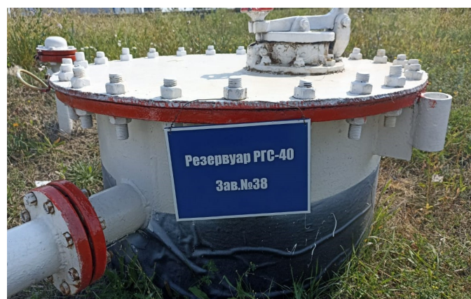
Рисунок 1 - Место нанесения заводских номеров резервуаров РГС-40
