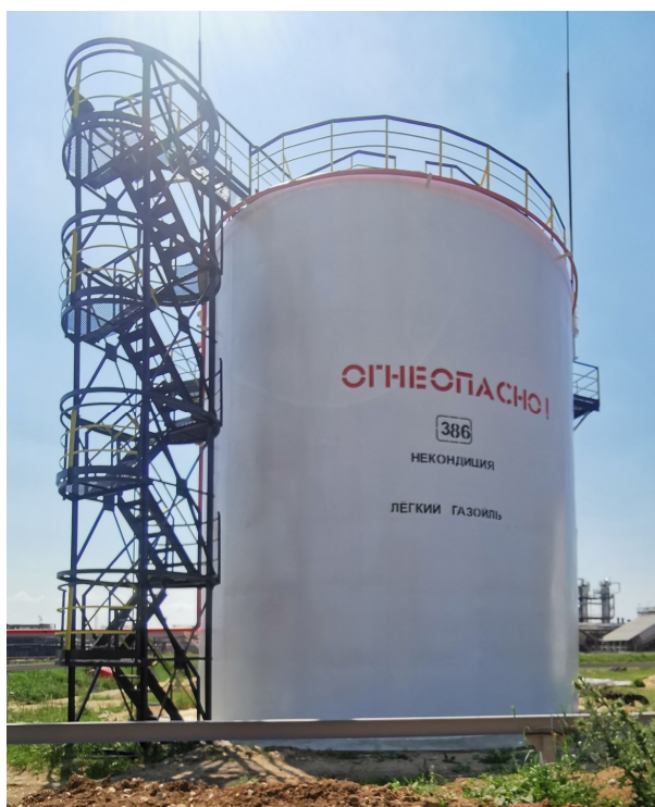
Рисунок 1 – Общий вид резервуара РВС-1000
