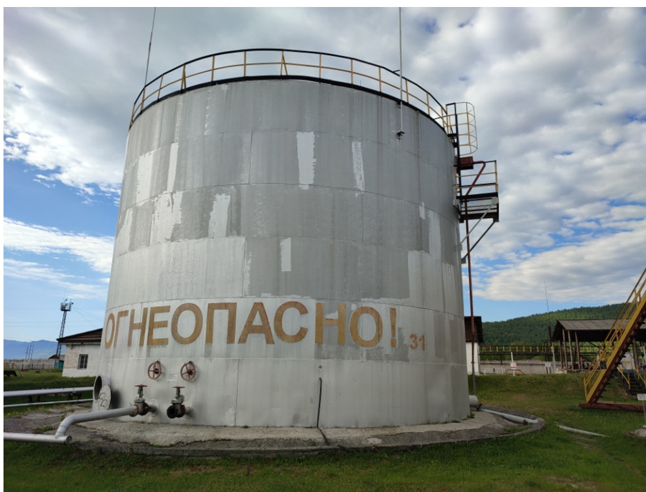
Рисунок 1 – Общий вид резервуара РВС-1000
