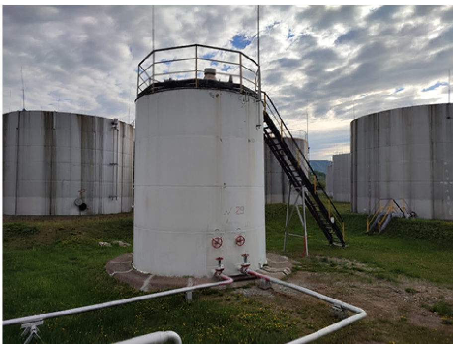
Рисунок 1 – Общий вид резервуара РВС-100
