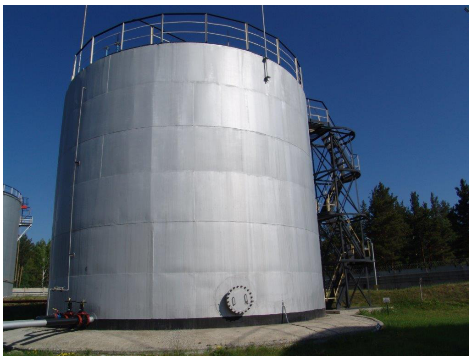
Рисунок 1 – Общий вид резервуара РВС-700
