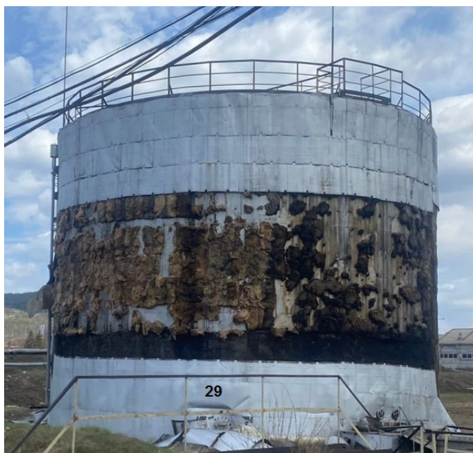
Рисунок 1 – Общий вид резервуара РВС-2000
