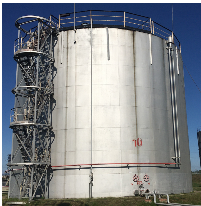
Рисунок 1 – Общий вид резервуара РВС-2000
