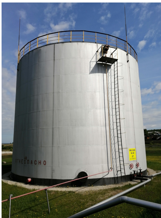
Рисунок 1 – Общий вид резервуара РВС-2000
