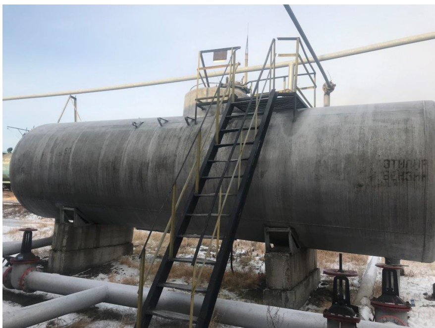
Рисунок 1 – Общий вид резервуара РГС-50
