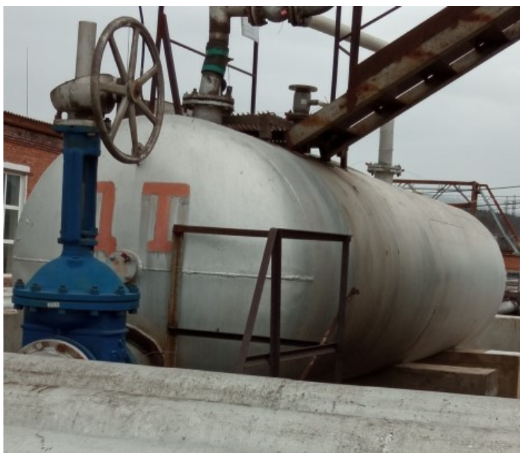
Рисунок 1 – Общий вид резервуара
