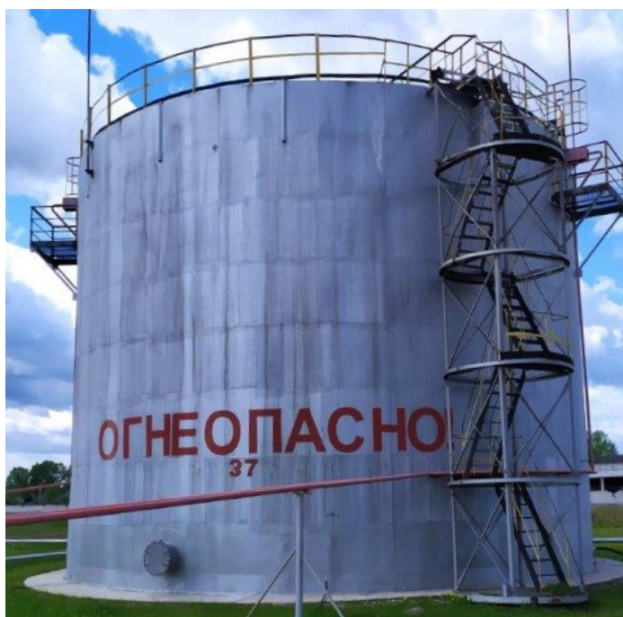
Рисунок 1 – Общий вид резервуара РВС-2000
