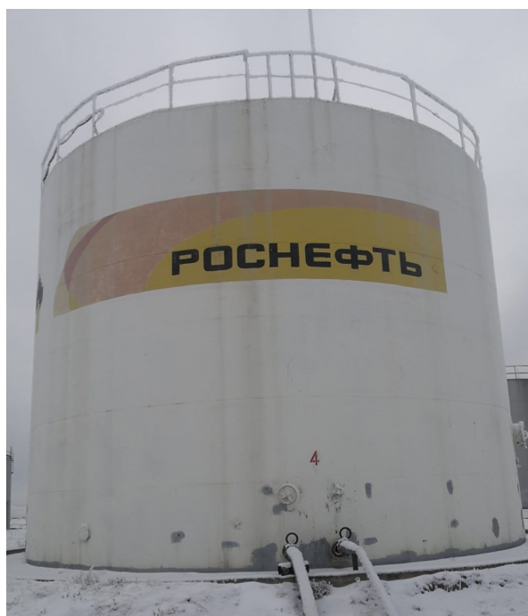
Рисунок 1 – Общий вид резервуаров РВС-1000
