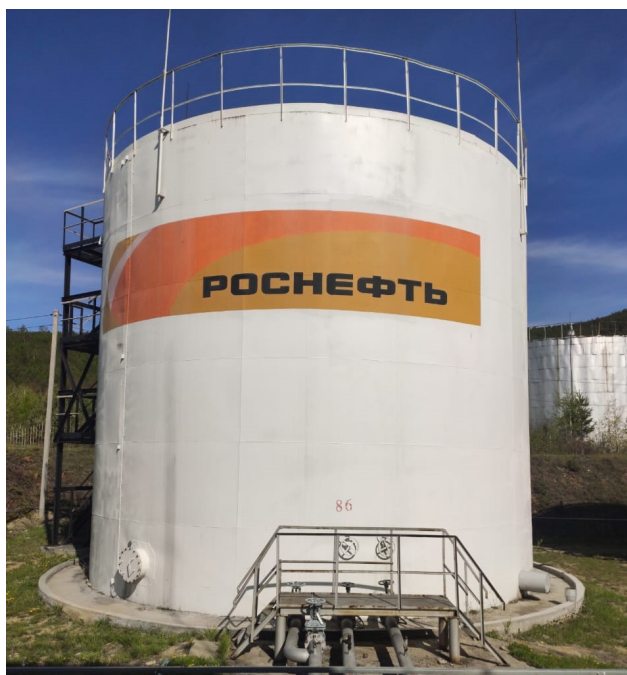
Рисунок 1 – Общий вид резервуаров РВС-700
