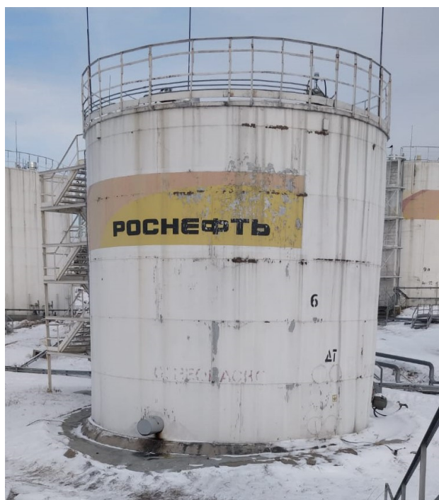
Рисунок 1 – Общий вид резервуара РВС-300
