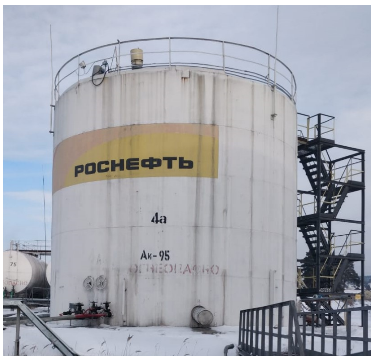
Рисунок 1 – Общий вид резервуара РВС-400
