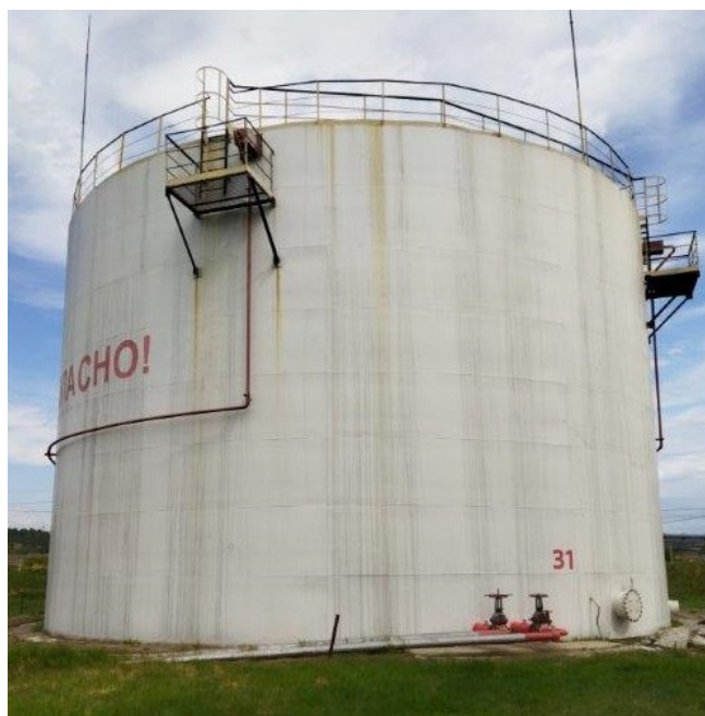
Рисунок 1 – Общий вид резервуаров РВС-3000
