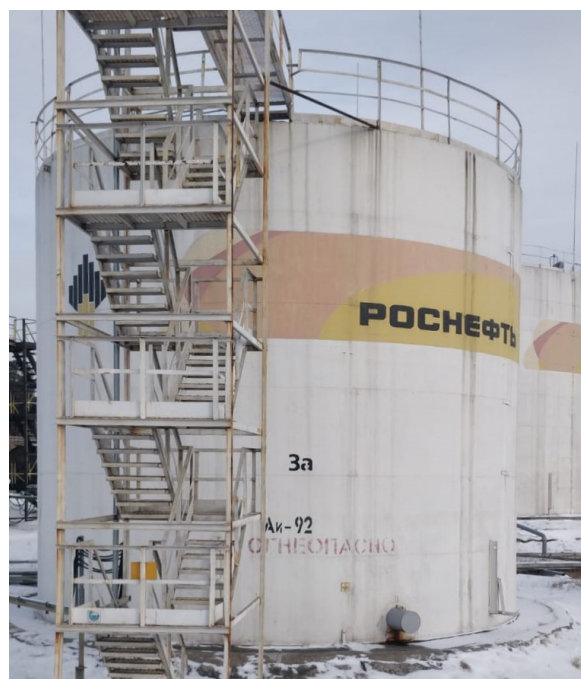
Рисунок 1 – Общий вид резервуара РВС-700
