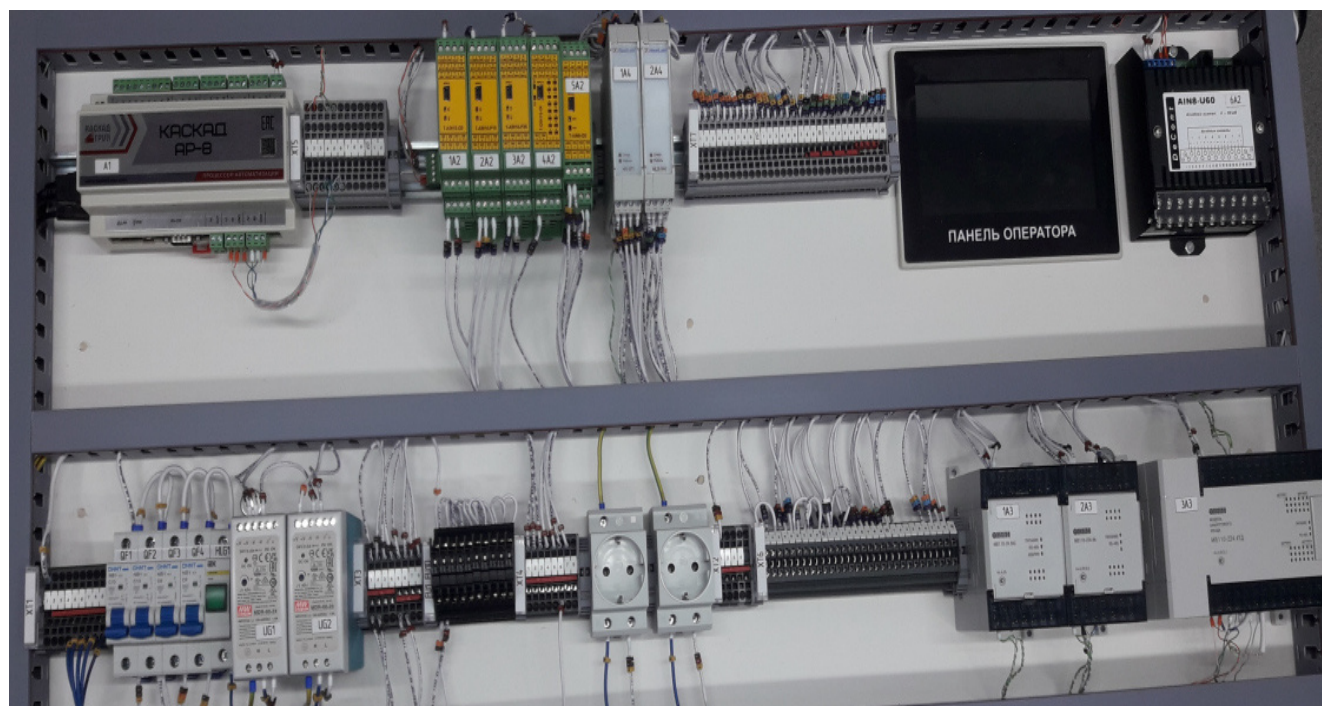
Рисунок 2 – Общий вид процессора автоматизации AP-8
