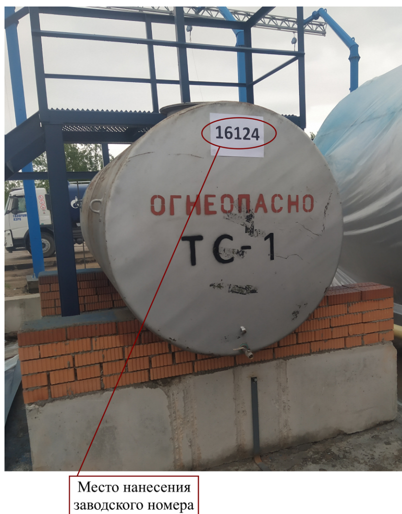
Рисунок 2 – Общий вид резервуара РГС-4 №16124 с указанием места нанесения заводского номера
