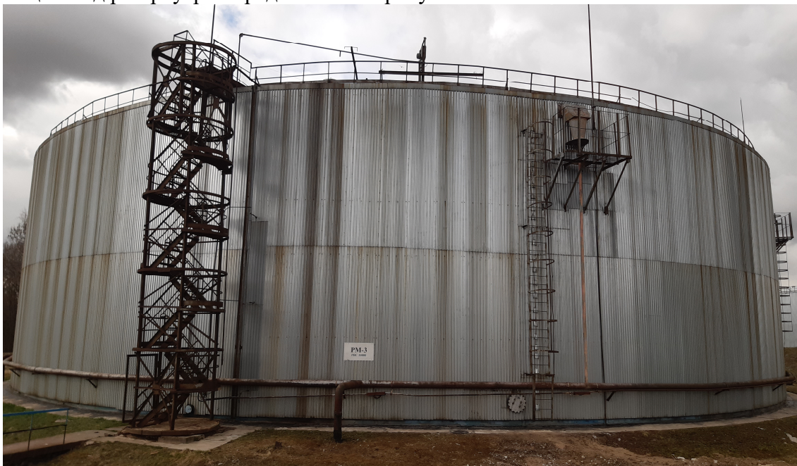
Рисунок 1 - Общий вида резервуара № РМ-3
