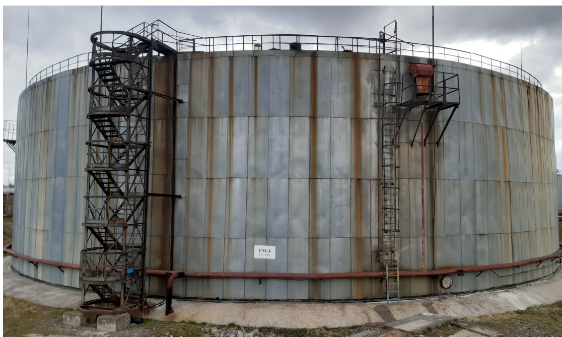
Рисунок 2 - Общий вида резервуара № РМ-4
