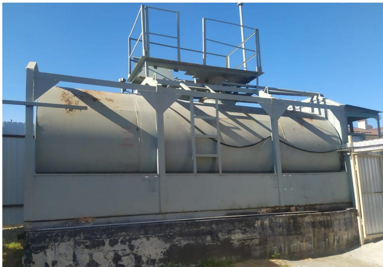
Рисунок 2 – Общий вид резервуара РГС-20
