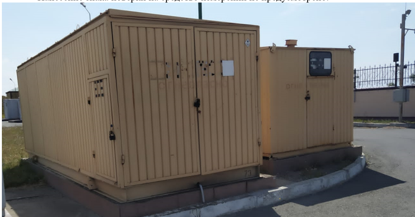
Рисунок 1 – Место расположения резервуаров РГС-5 с заводскими номерами 69/1, 69/2
