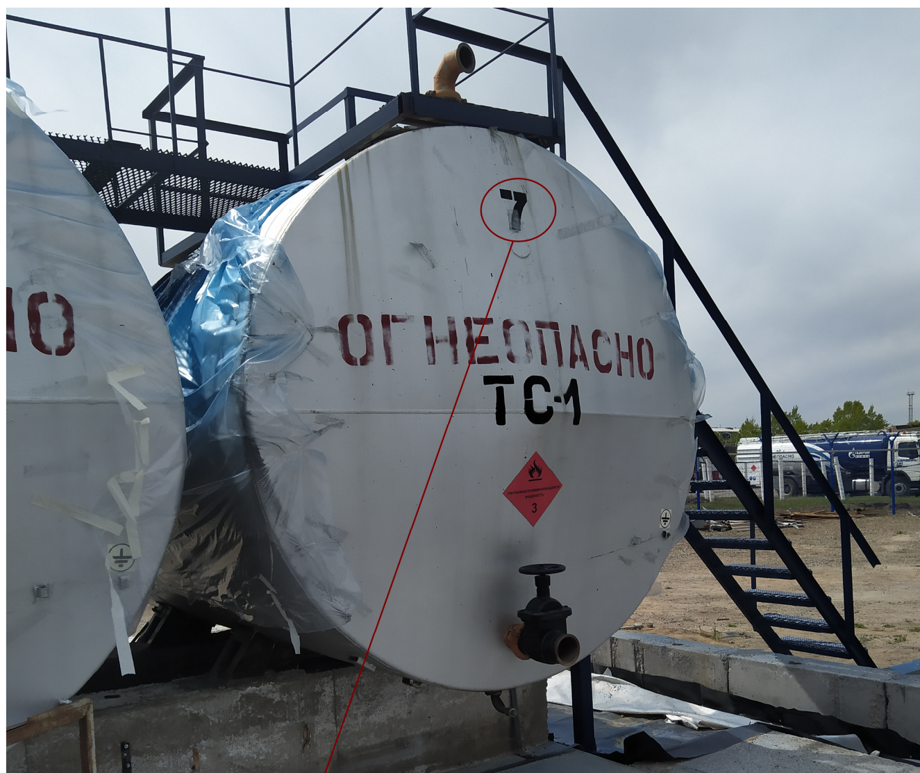
Рисунок 1 – Общий вид резервуара РГС-25 №7 с указанием места нанесения заводского номера
