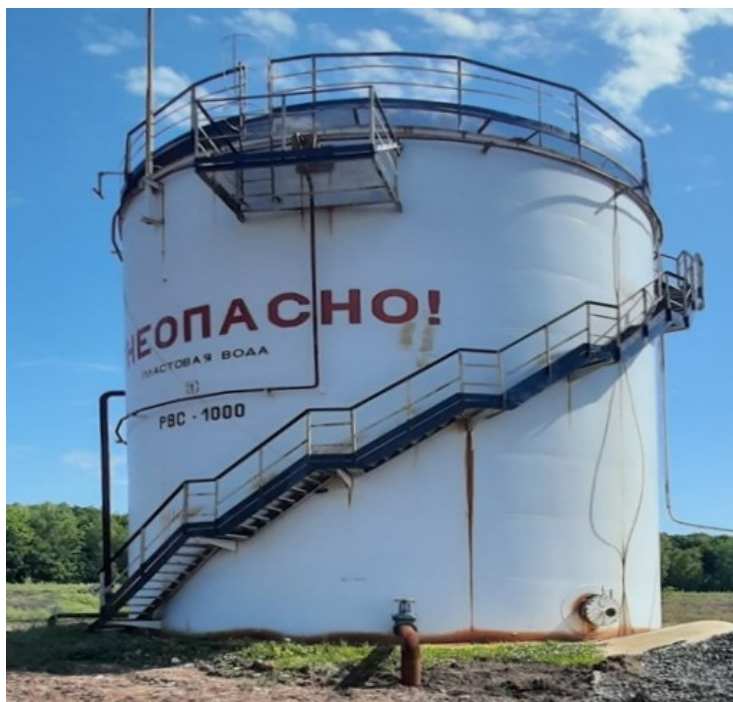
Рисунок 1 – Общий вид резервуара РВС-1000
