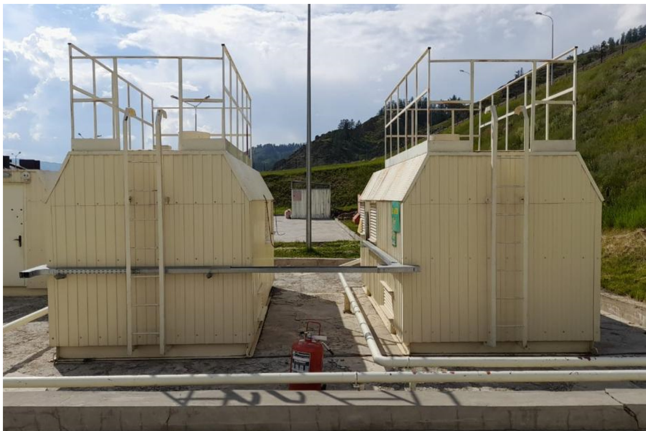
Рисунок 1 – Место расположения резервуаров
