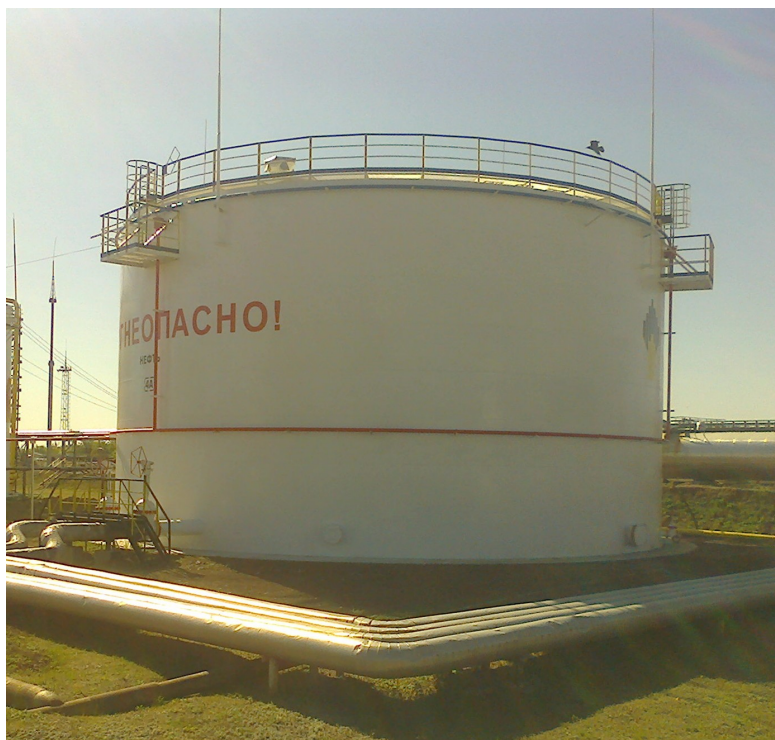
Рисунок 1 – Общий вид резервуара РВС-5000
