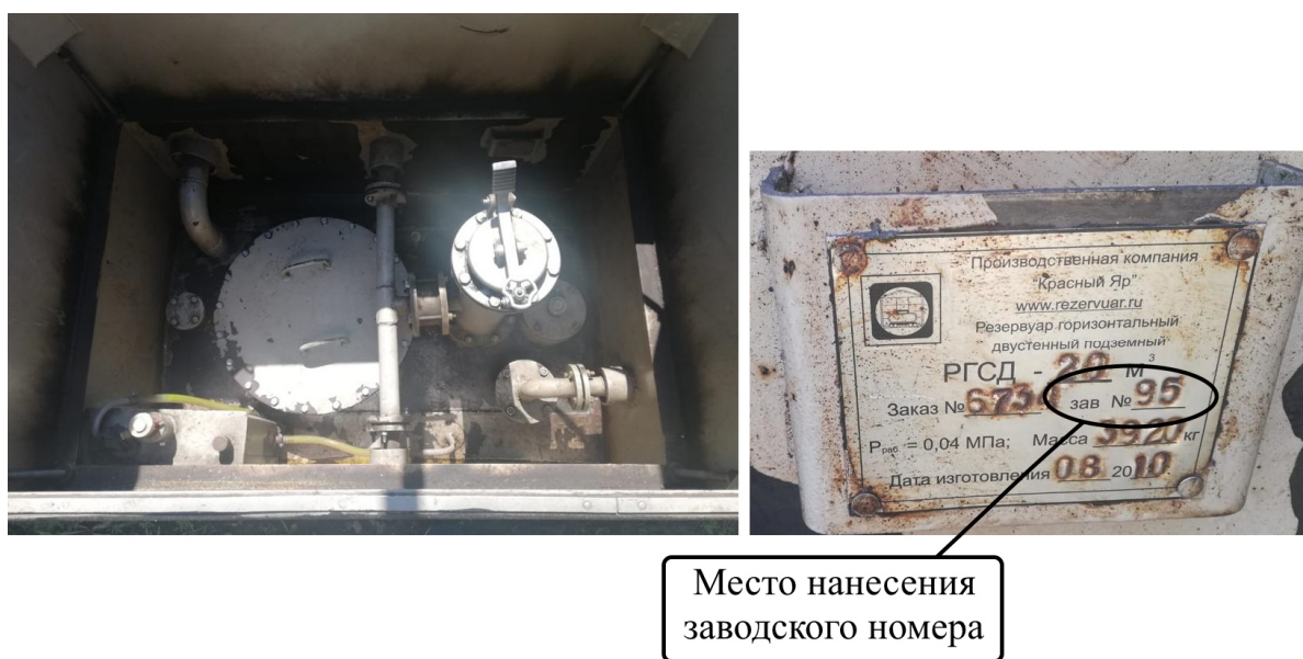
Рисунок 3 – Общий вид резервуара РГСД-20 №95 с указанием места нанесения заводского номера
