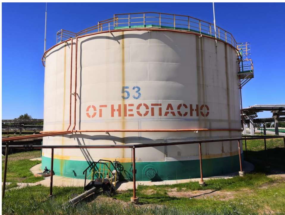
Рисунок 1 – Общий вид резервуаров РВС-5000
