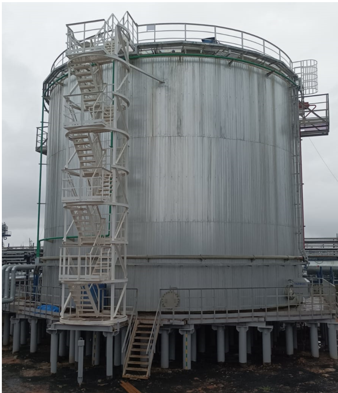
Рисунок 1 – общий вид РВС-2000
