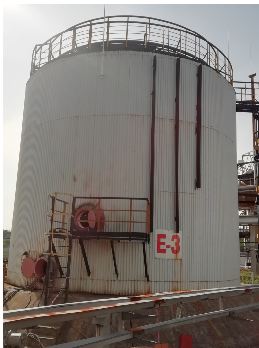
Рисунок 1 – Общий вид резервуара РВСП-700
