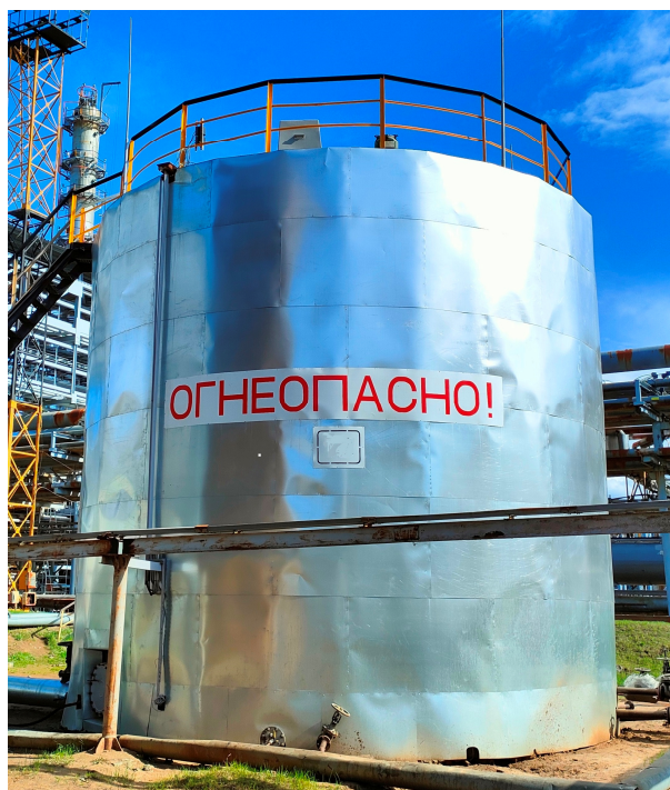
Рисунок 1 – Общий вид резервуара РВС-300
