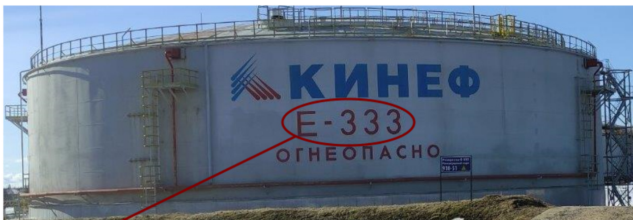
Рисунок 9 – Общий вид резервуара РВС-20000 № Е-332 с указанием места нанесения заводского номера
