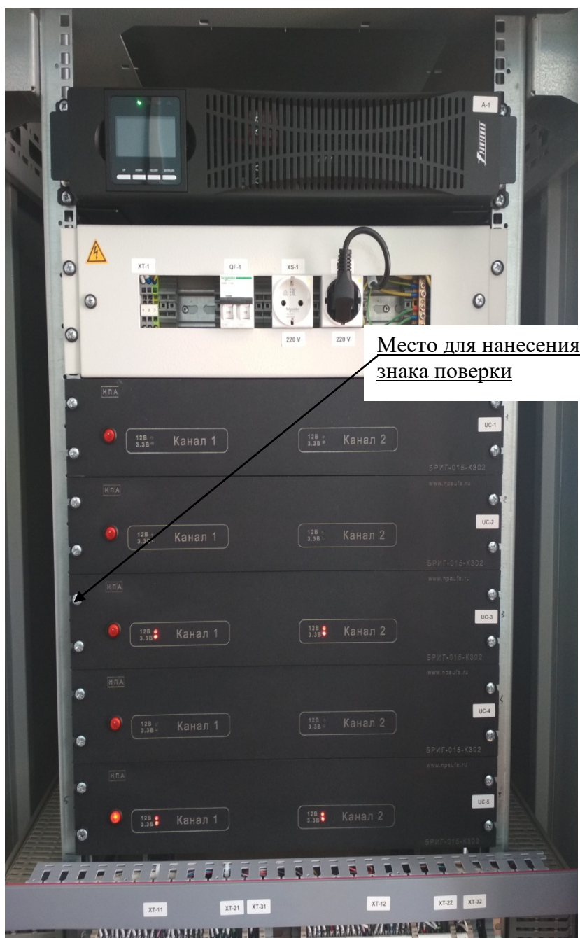
Рисунок 2 – Схема пломбировки контроллера БРИГ-015-К302
