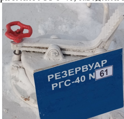
Рисунок 3 – Фотография горловины и заводского номера резервуара стального горизонтального цилиндрического РГС-40, заводской номер 61
