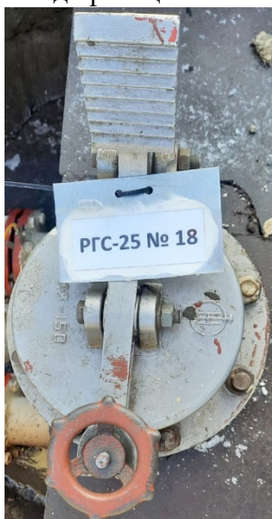
Рисунок 5 – Фотография горловины и заводского номера резервуара стального горизонтального цилиндрического РГС модификации РГС-25, заводской номер 18
