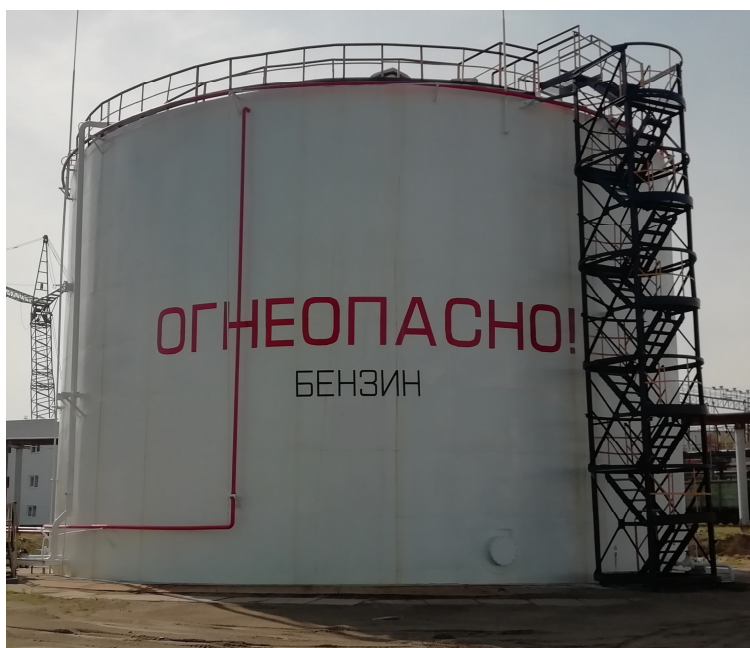
Рисунок 1 – Общий вид резервуаров РВС-3000
