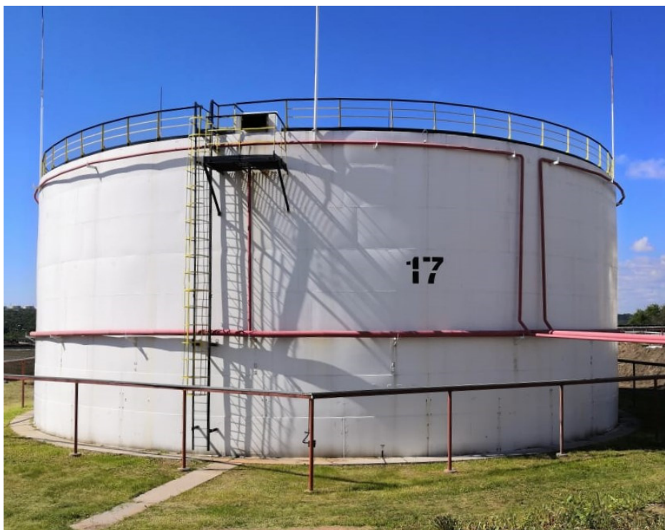
Рисунок 1 – Общий вид резервуаров РВС-8000
