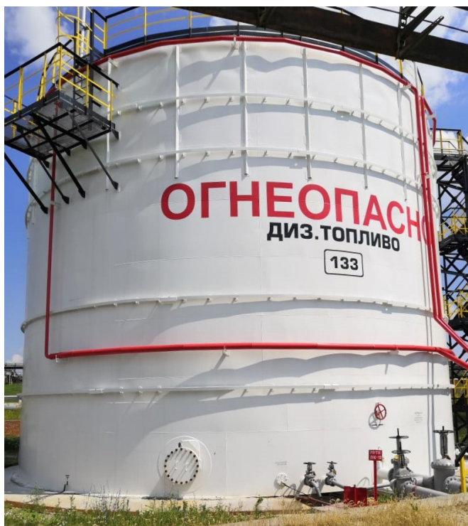
Рисунок 1 – Общий вид резервуаров РВС-2000
