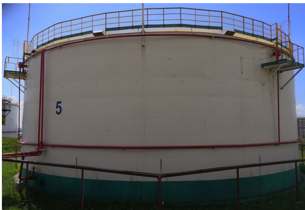
Рисунок 1 – Общий вид резервуаров РВСП-8000
