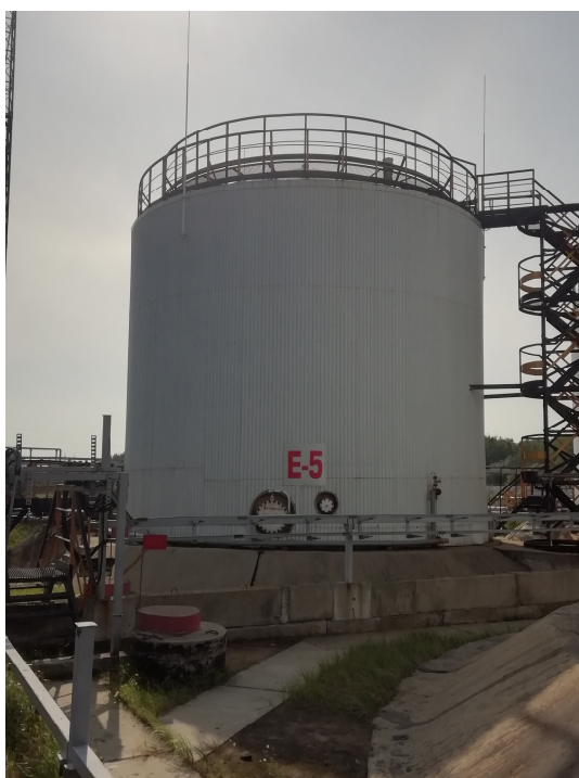
Рисунок 1 – Общий вид резервуаров РВС-700
