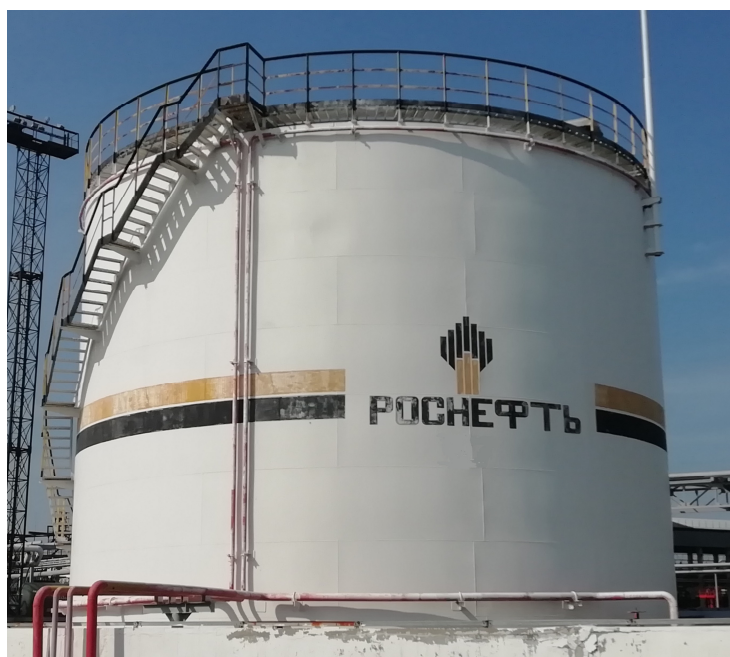
Рисунок 1 – Общий вид резервуаров РВС-2000
