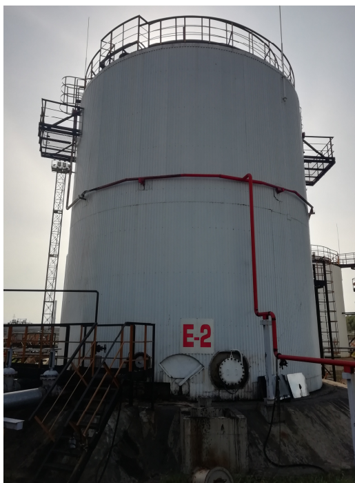
Рисунок 1 – Общий вид резервуаров РВС-1000
