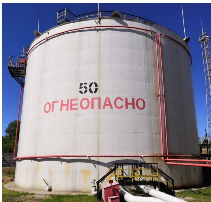
Рисунок 1 – Общий вид резервуаров РВСП-5000
