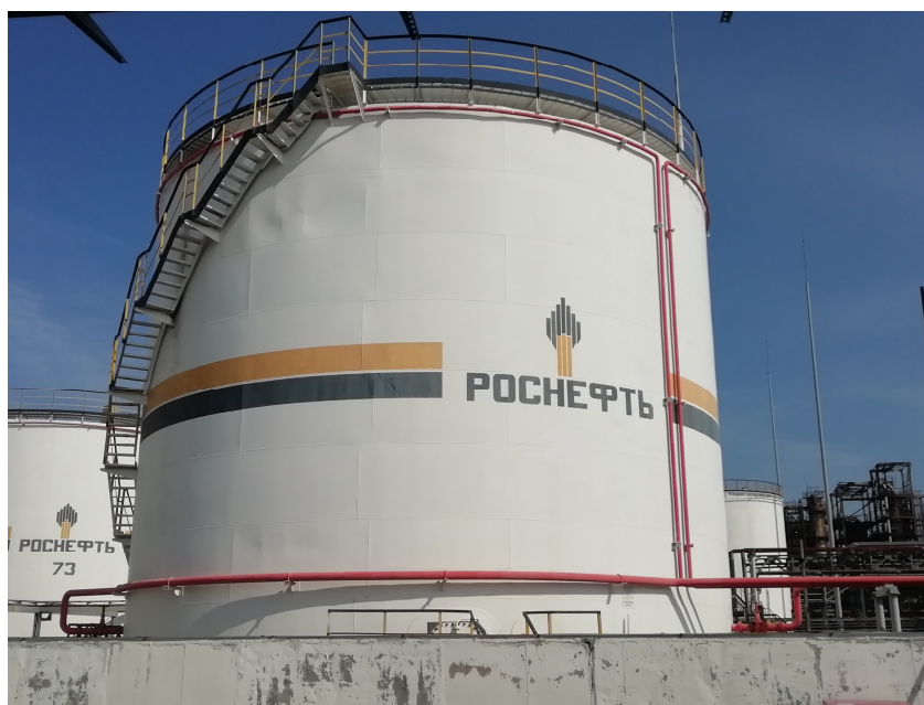
Рисунок 1 – Общий вид резервуаров РВС-2000
