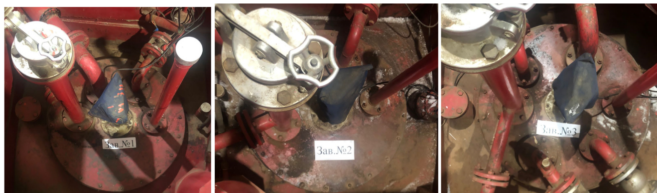
Рисунок 1 – Общий вид резервуаров РГС-25
