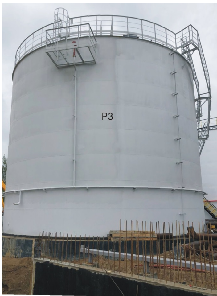
Рисунок 3 – Общий вид резервуара РВС-2000 зав.№ Р3
