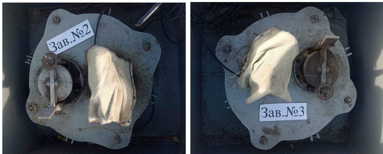
Рисунок 1 – Общий вид резервуаров РГС-60
