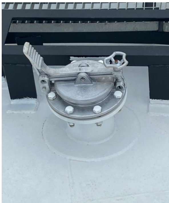
Рисунок 5 – Фото замерного люка резервуаров РВС-2000
