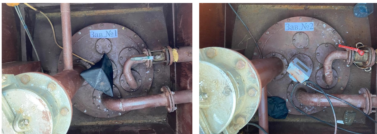
Рисунок 1 – Общий вид резервуаров РГС-25
