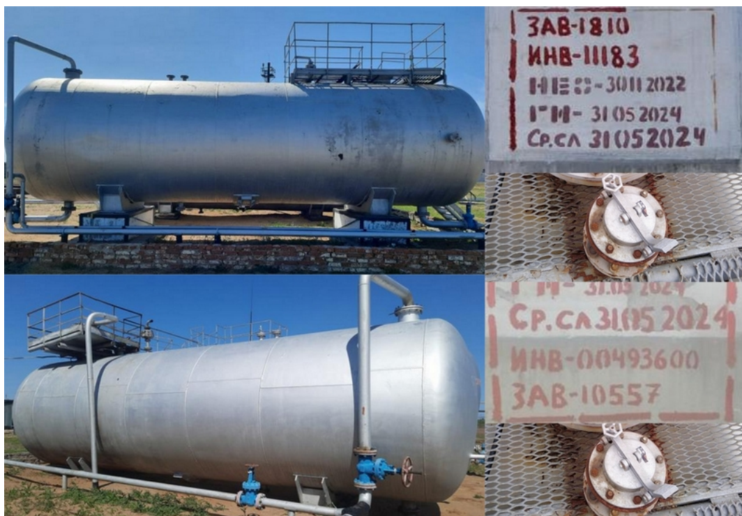
Рисунок 1 – Общий вид резервуаров стальных горизонтальных цилиндрических РГС-72 их горловин и заводских номеров
