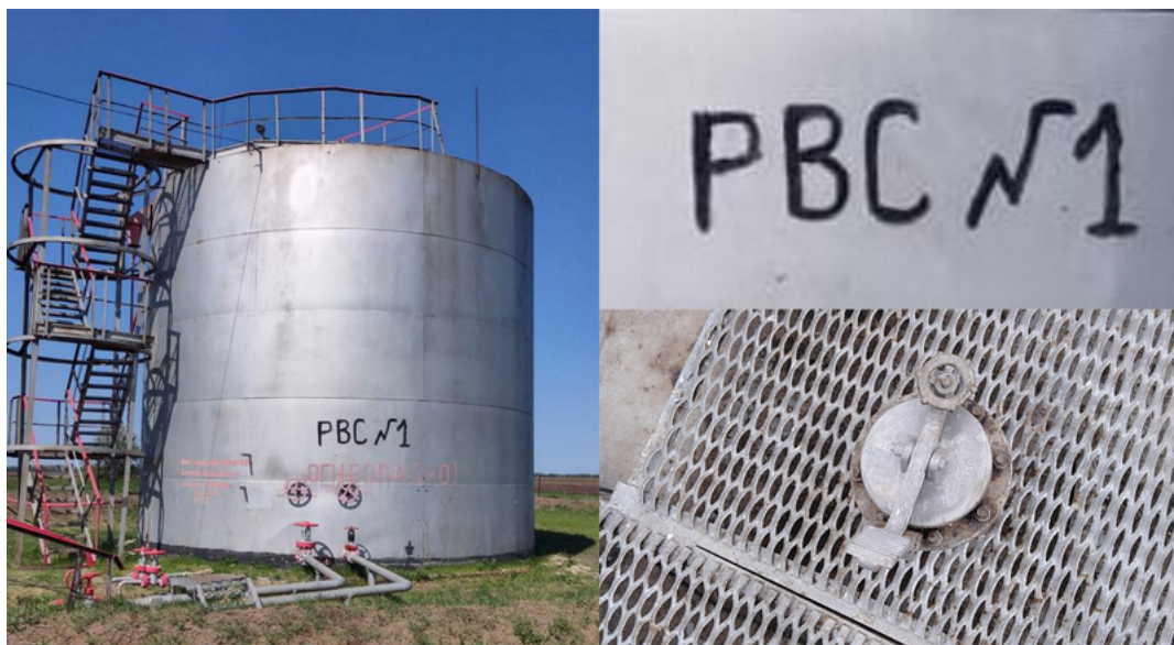
Рисунок 1 – Общий вид резервуара стального вертикального цилиндрического РВС-400
