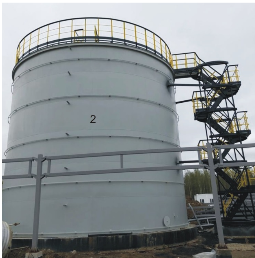
Рисунок 2 – Общий вид резервуара РВС-700 зав.№ 2
