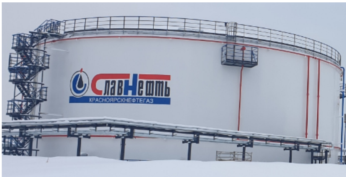
Рисунок 1 – Общий вид резервуара РВС-10000
