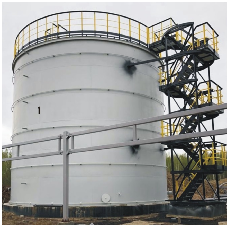
Рисунок 1 – Общий вид резервуара РВС-700 зав.№ 1
