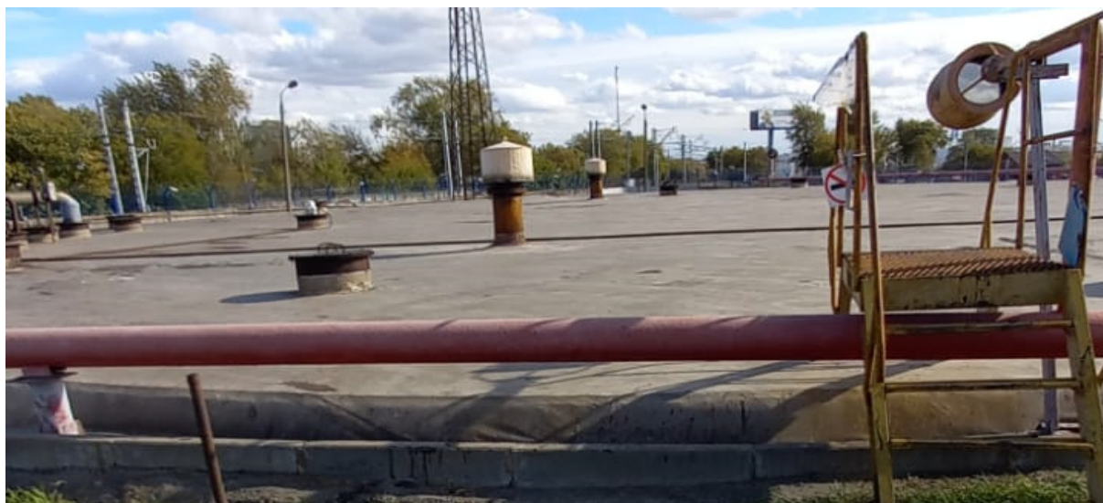
Рисунок 1 – Общий вид резервуара ЖБР-10000
