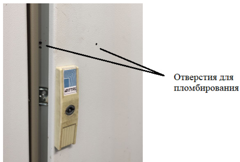
Рисунок 4 – Схема пломбировки шкафа СОИ
