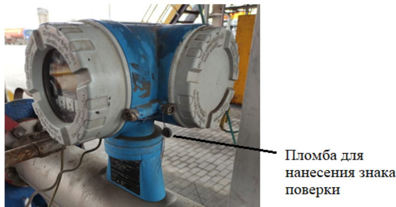
Рисунок 5 – Схема пломбировки электронного преобразователя 83 Promass
