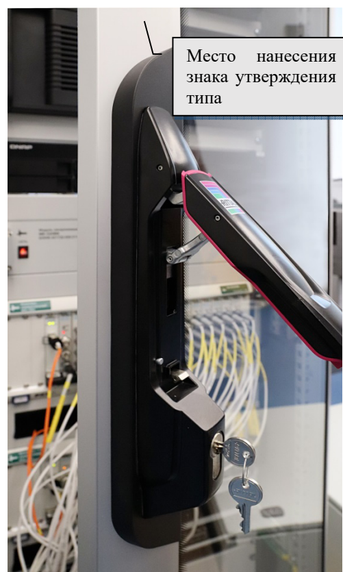
Рисунок 2 – Запирающий механизм стойки.
