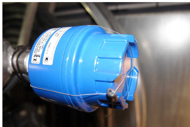
Рисунок 13 – Пломбирование датчика температуры
