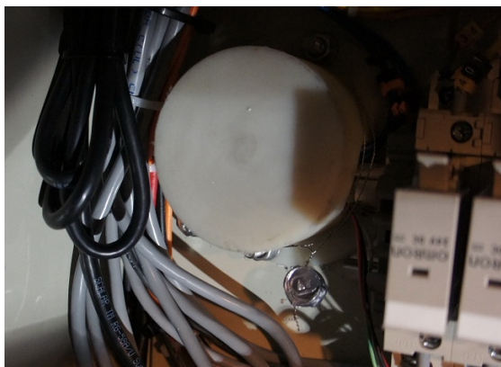
Рисунок 12 – Пломбирование преобразователей температуры PR, ПСТ, ИП 0304/М3-Н
