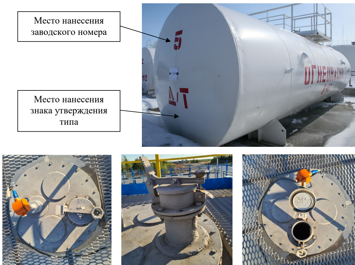
Рисунок 1 – Общий вид резервуара с указанием места нанесения знака утверждения типа, места нанесения заводского номера
