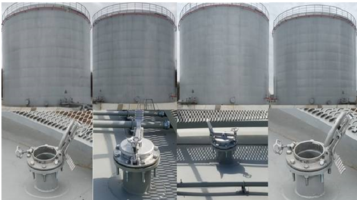
Рисунок 1 – Общий вид резервуаров РВС-5000
