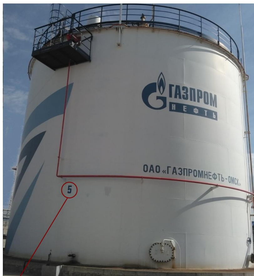
Место нанесения заводского номера
