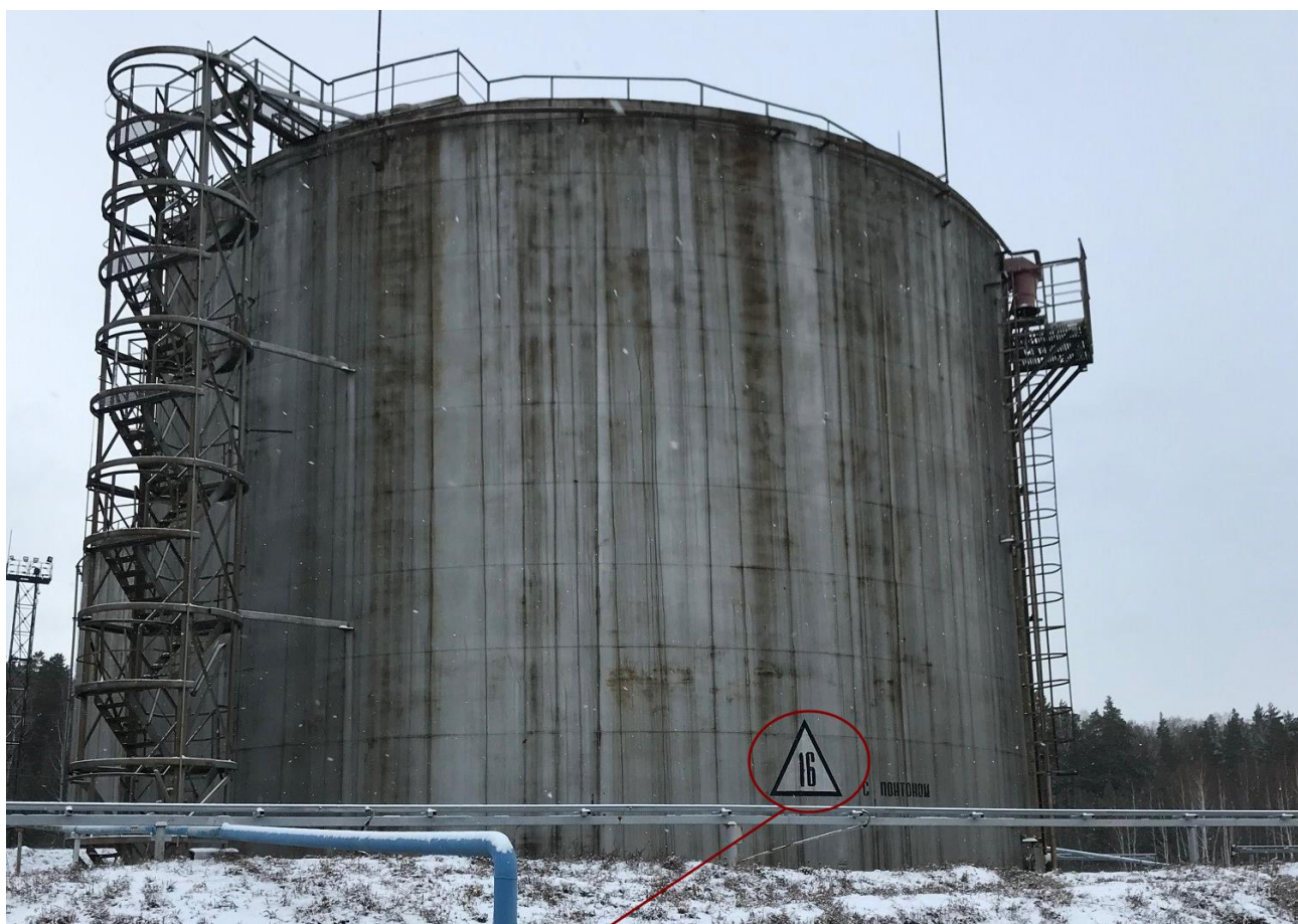
Место нанесения заводского номера
