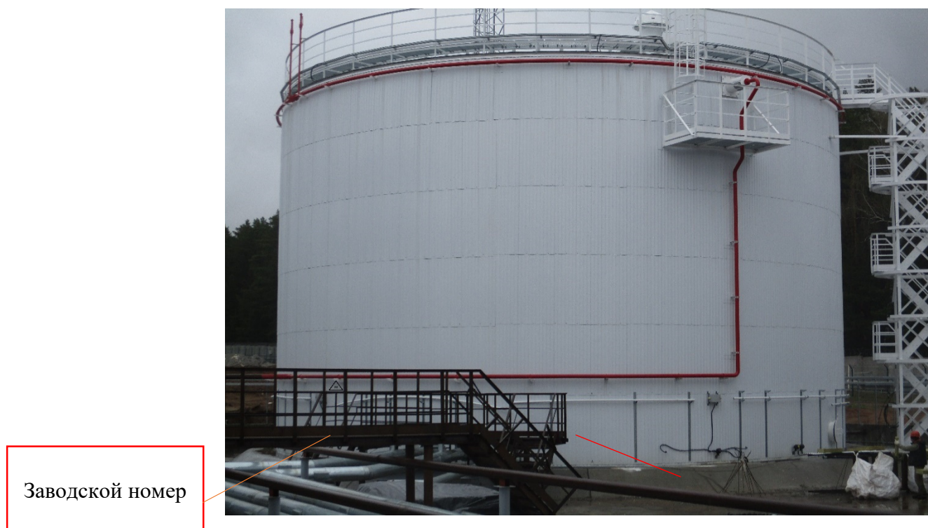
Рисунок 1 - Общий вид резервуара вертикального стального цилиндрического РВС-3000 заводской номер 30 с указанием места нанесения заводского номера
