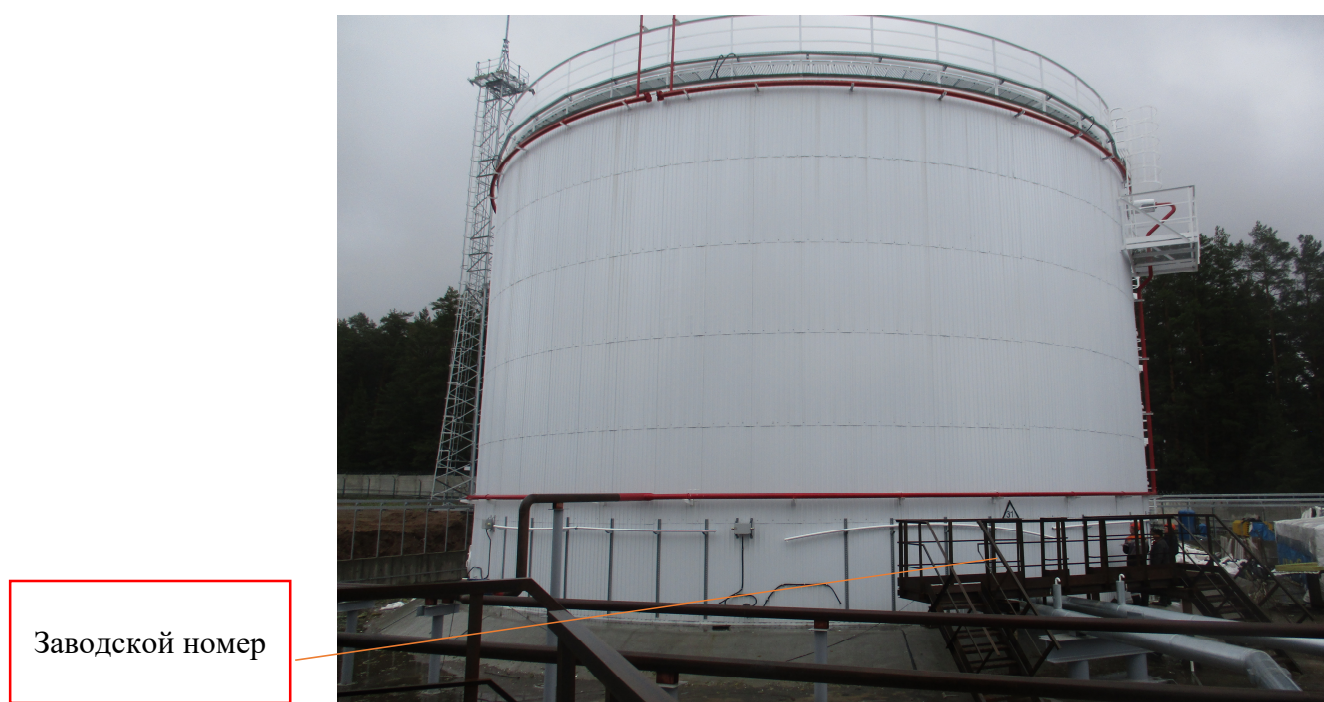
Рисунок 2 - Общий вид резервуара вертикального стального цилиндрического РВС-3000 заводской номер 31 с указанием места нанесения заводского номера
