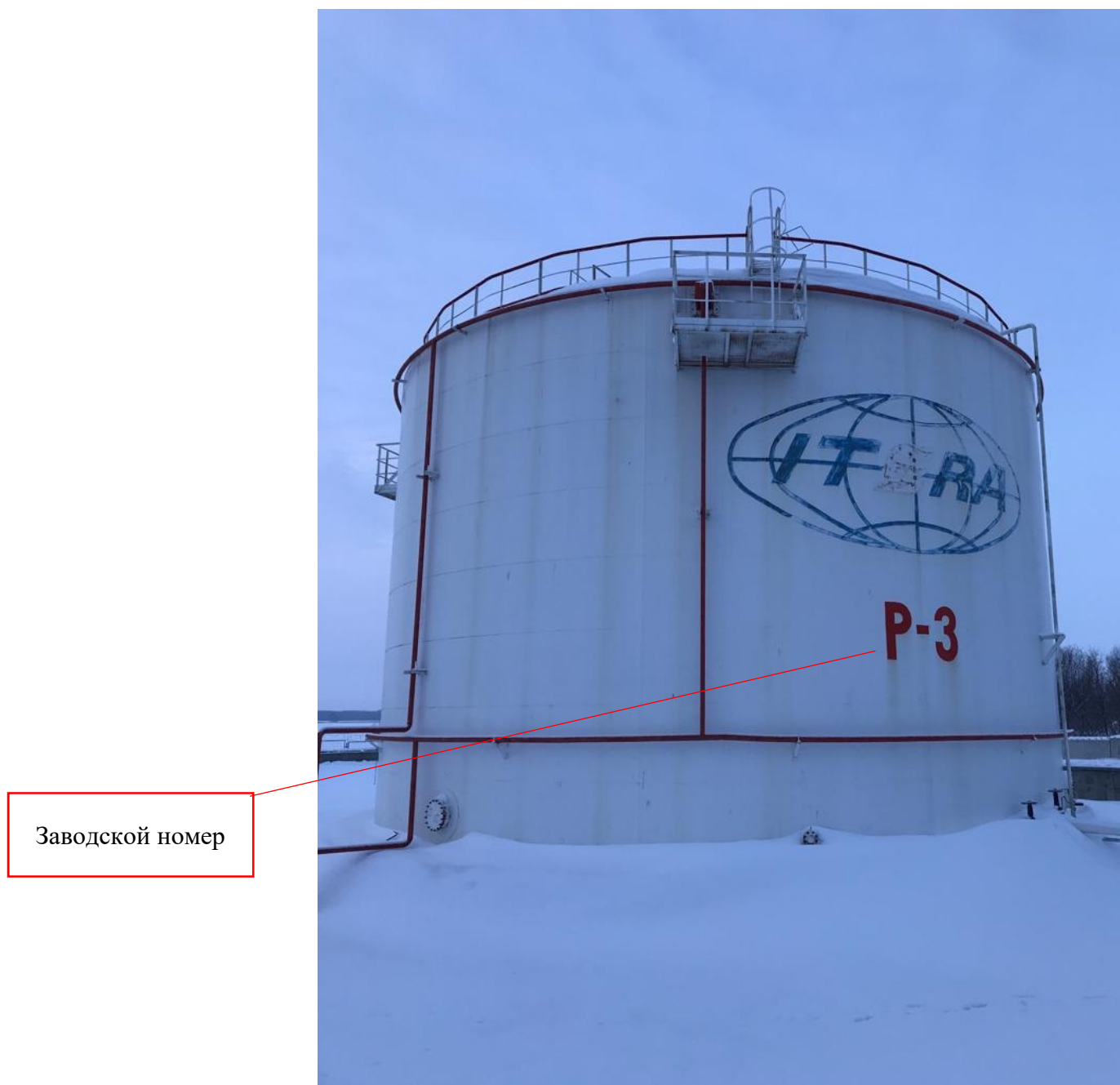
Рисунок 1 - Общий вид резервуара вертикального стального цилиндрического РВС-3000 заводской номер Р-3 с указанием места нанесения заводского номера
