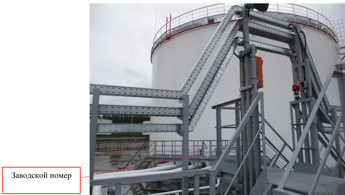
Рисунок 1 - Общий вид резервуара вертикального стального цилиндрического РВСП-5000 заводской номер 1 с указанием места нанесения заводского номера
