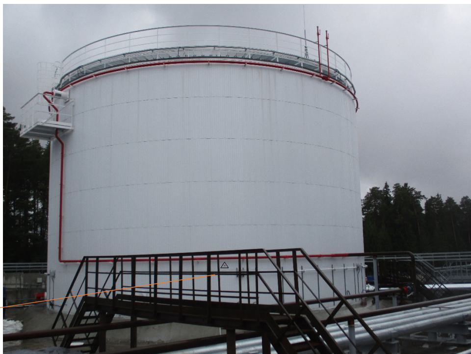
Рисунок 3 - Общий вид резервуара вертикального стального цилиндрического РВС-3000 заводской номер 32 с указанием места нанесения заводского номера
