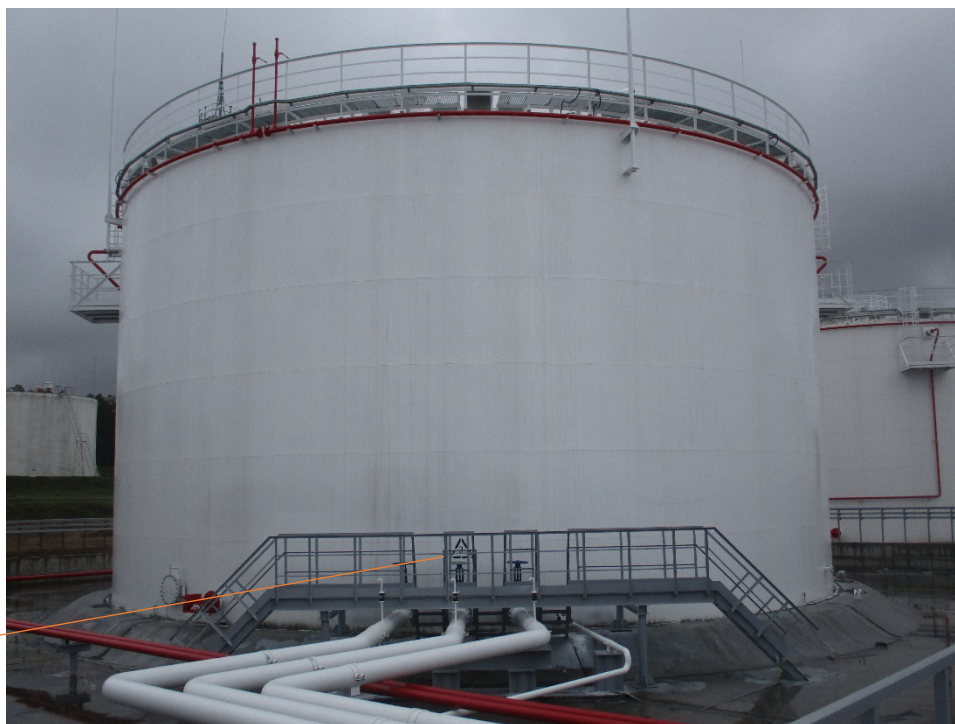
Рисунок 3 - Общий вид резервуара вертикального стального цилиндрического РВСП-5000 заводской номер 3 с указанием места нанесения заводского номера
