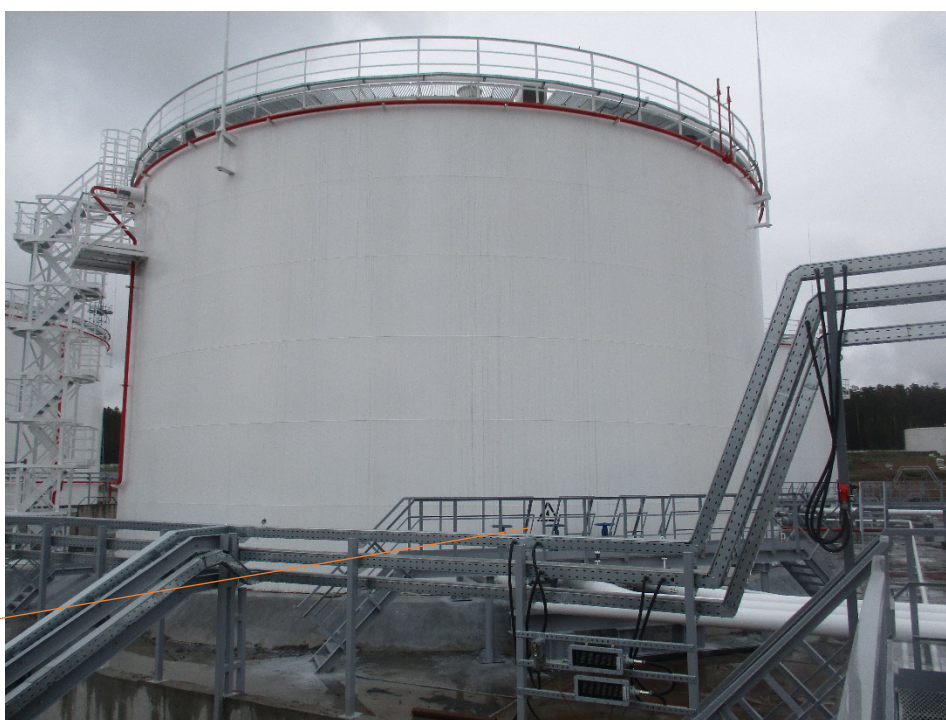
Рисунок 4 - Общий вид резервуара вертикального стального цилиндрического РВСП-5000 заводской номер 4 с указанием места нанесения заводского номера
