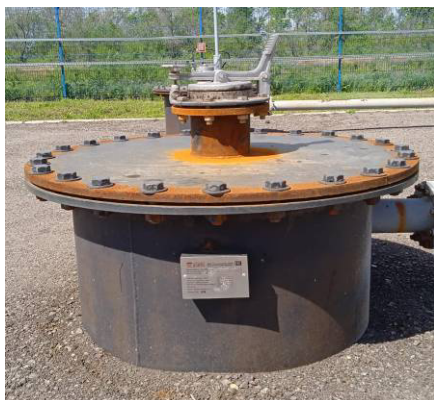
Рисунок 5 – Заводской номер, горловина и замерный люк резервуара горизонтального стального РГСП-100 заводской номер 14
