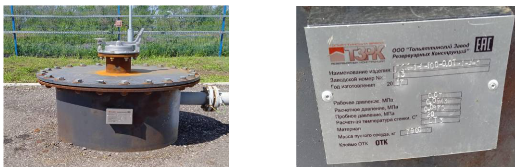
Рисунок 3 – Заводской номер, горловина и замерный люк резервуара горизонтального стального РГСп-100 заводской номер 13
