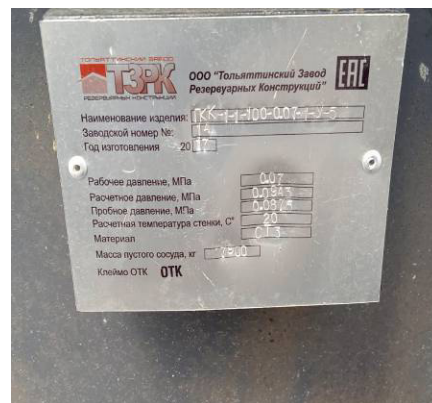
Рисунок 5 – Заводской номер, горловина и замерный люк резервуара горизонтального стального РГСП-100 заводской номер 14
