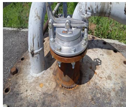
Рисунок 5 – Заводской номер, горловина и замерный люк резервуара горизонтального стального РГСП-100 заводской номер 14
