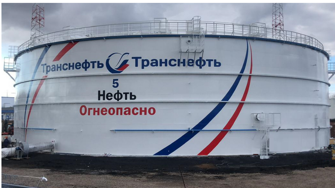
Рисунок 1 – Общий вид резервуара РВСП-20000
