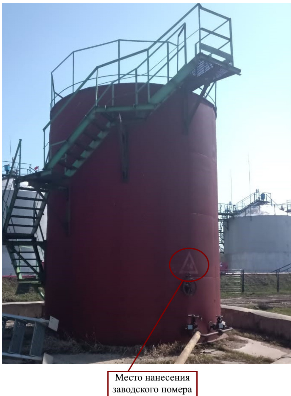
Рисунок 1 – Общий вид резервуара РВС-100 с указанием места нанесения заводского номера
