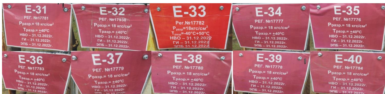
Рисунок 2 – Место нанесения заводских номеров резервуаров РГС-200
