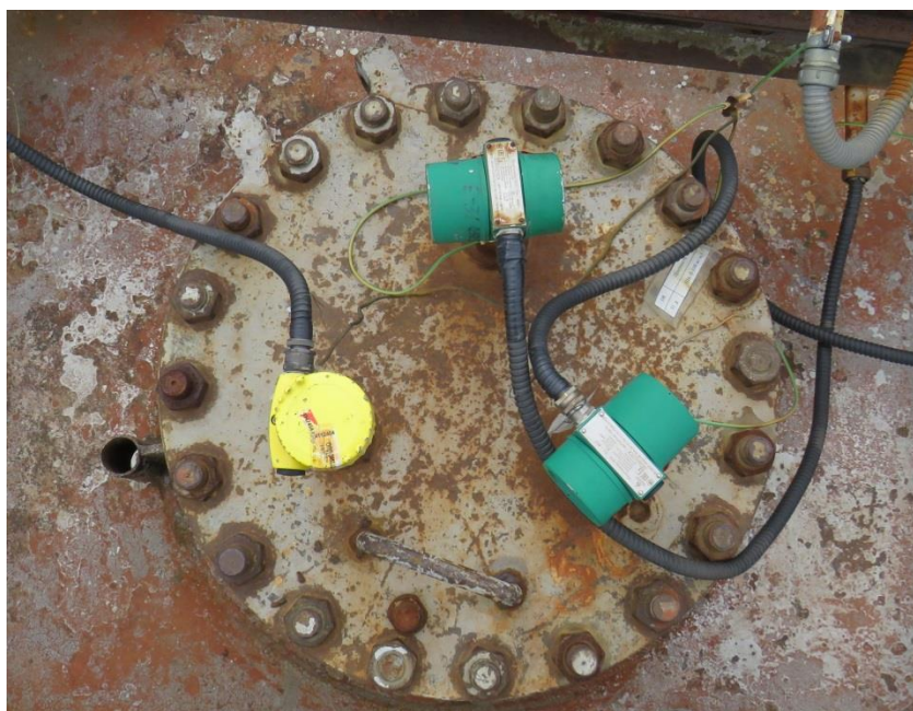
Рисунок 3 – Фото горловины и замерного люка резервуаров РГС-200
