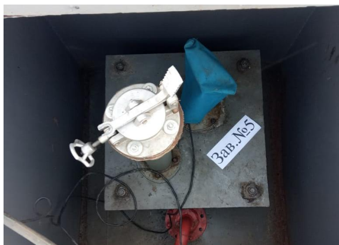
Рисунок 1 – Общий вид резервуара РГС-15
