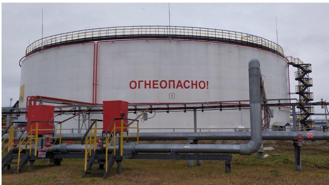
Рисунок 1 – Общий вид резервуаров РВС-20000
