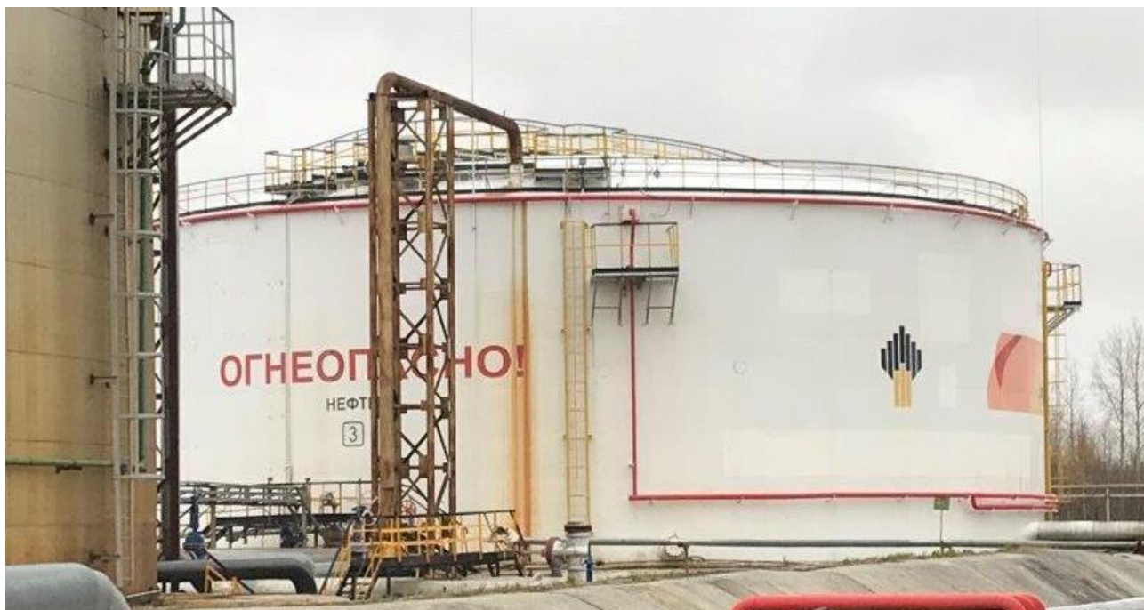
Рисунок 1 – Общий вид резервуаров РВС-10000
