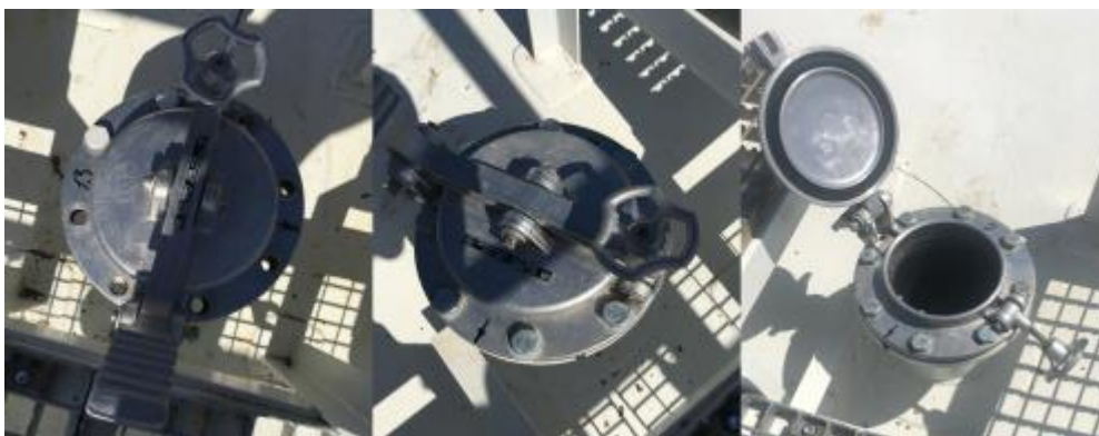
Рисунок 2 – Общий вид горловин и замерных люков резервуаров стальных вертикальных цилиндрических РВС-10000
