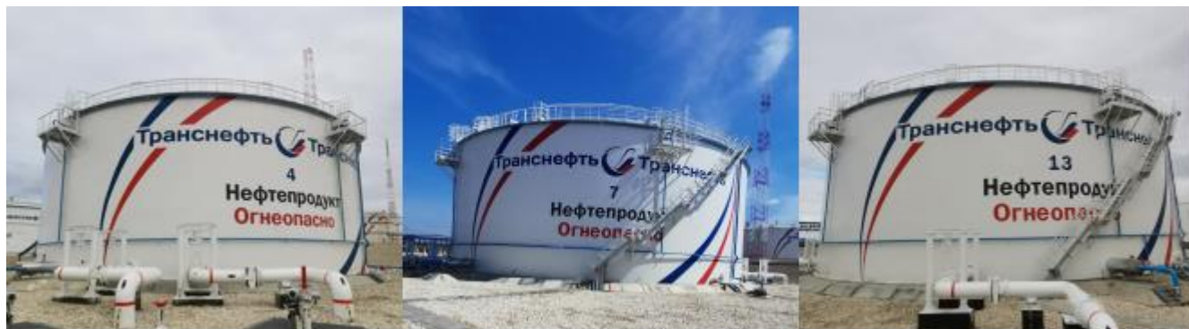
Рисунок 1 – Общий вид резервуаров стальных вертикальных цилиндрических РВС-10000
