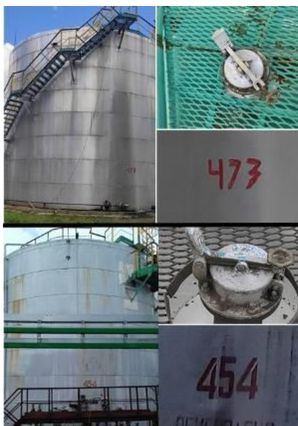
Рисунок 3 – Общий вид резервуаров стальных вертикальных цилиндрических РВС-700 №№ 454, 473 их горловин и заводских номеров
