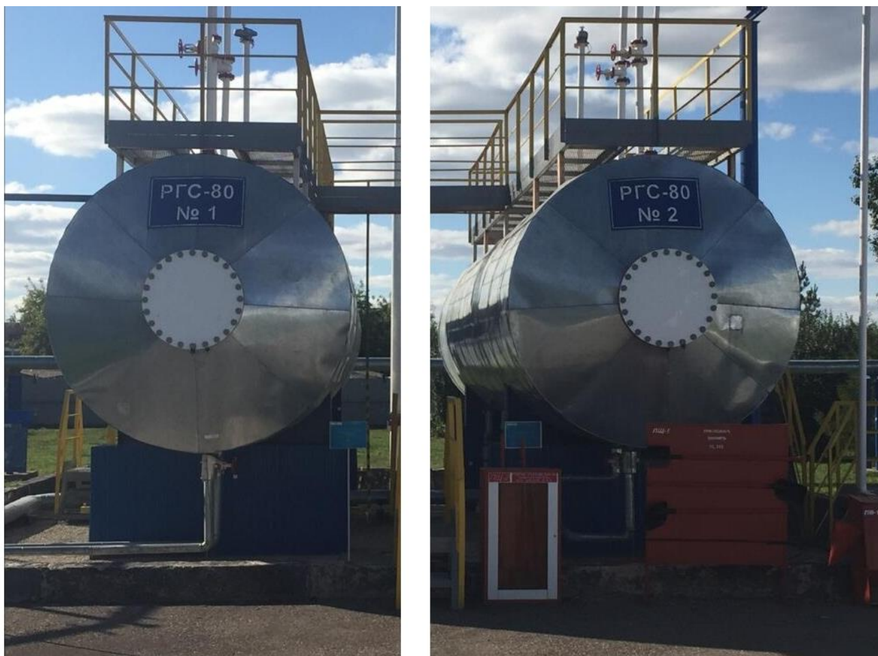
Рисунок 2 – Общий вид резервуаров PGC-80
