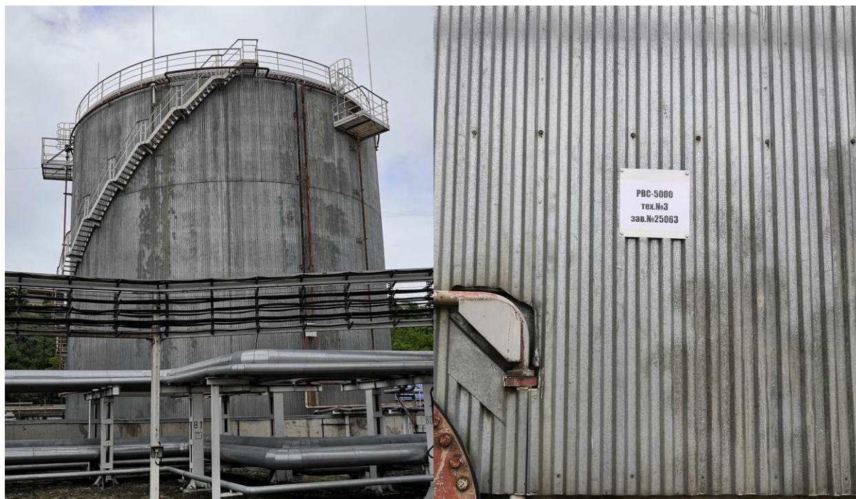
Рисунок 6 - Общий вид резервуара стального вертикального цилиндрического теплоизолированного РВС-5000, заводской № 25063
