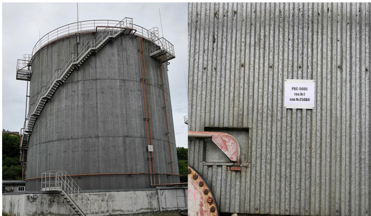
Рисунок 7 - Общий вид резервуара стального вертикального цилиндрического теплоизолированного РВС-5000, заводской № 25064
