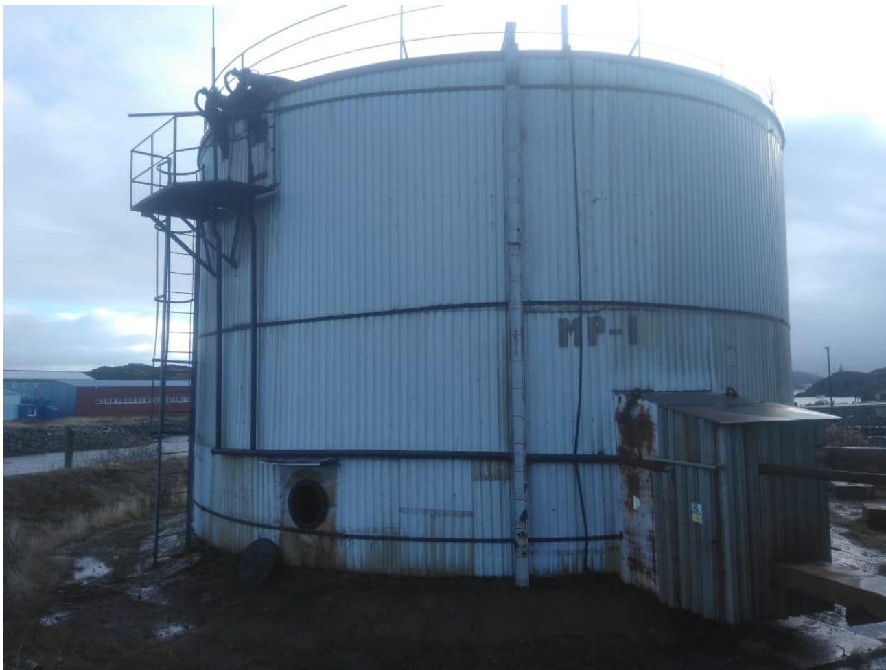
Рисунок 1 – Общий вид резервуара РВС-1000
