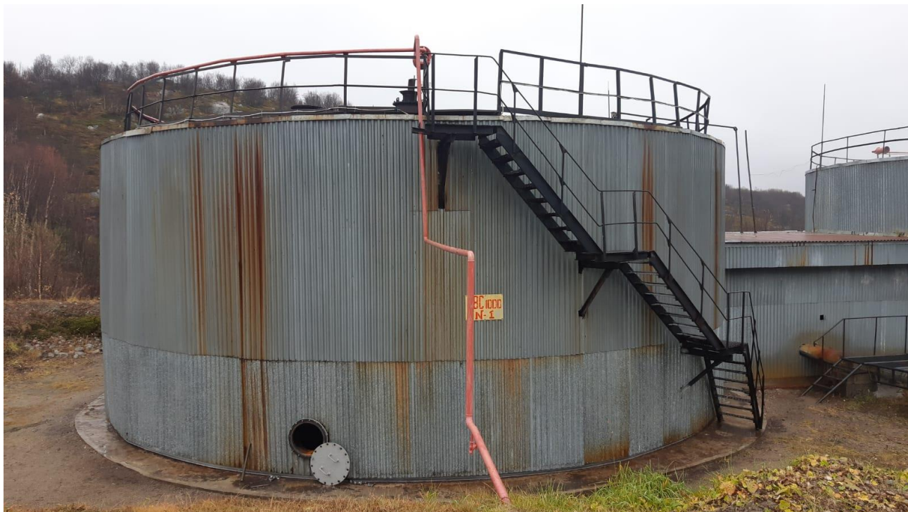
Рисунок 1 – Общий вид резервуара РВС-1000
