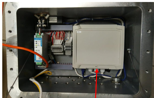
Место пломбировки
