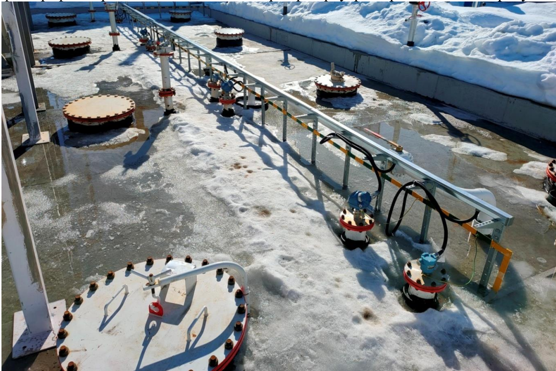
Рисунок 1 – Общий вид площадки размещения резервуаров горизонтальных стальных цилиндрических РГС-100
