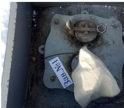
Рисунок 1 – Общий вид резервуара РГС-70
