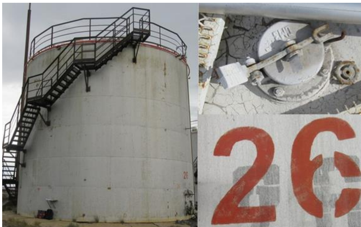
Рисунок 1 – Общий вид резервуара РВС-700 заводской номер 26
