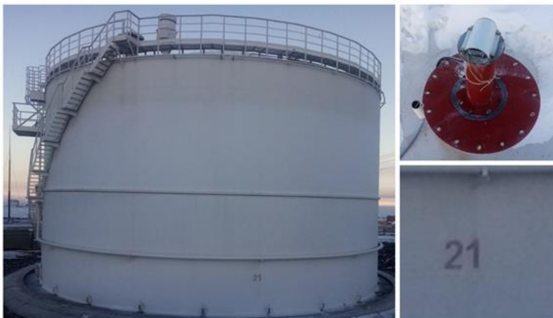
Рисунок 5 – Общий вид резервуара РВС-5000 заводской номер 21
