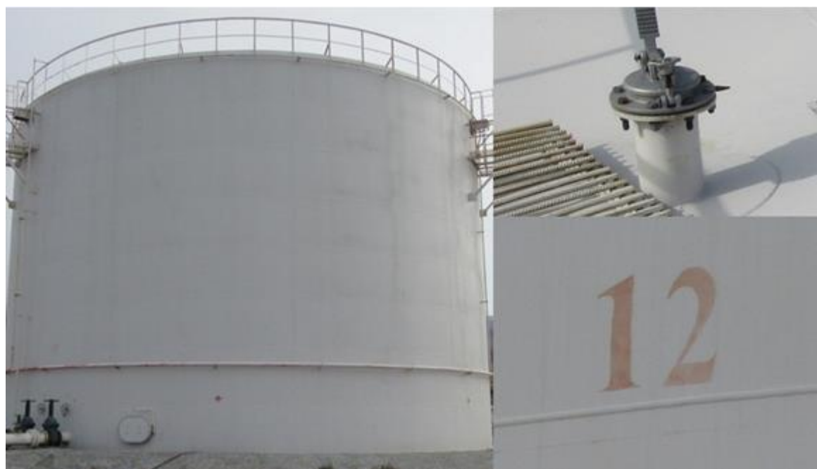
Рисунок 2 – Общий вид резервуара РВС-3000 заводской номер 12
